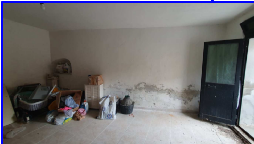
Particolare sgombero con vista verso l'ingresso
