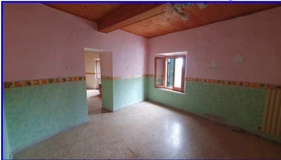
Particolare camera n.1 con vista dalla porta di accesso verso la Camera n.2
