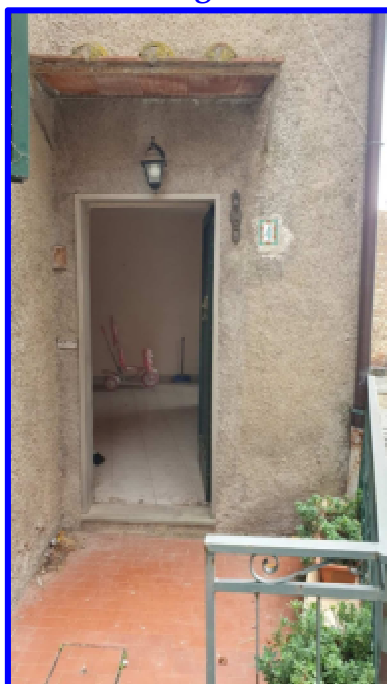
Particolare porta di ingresso al piano terra
