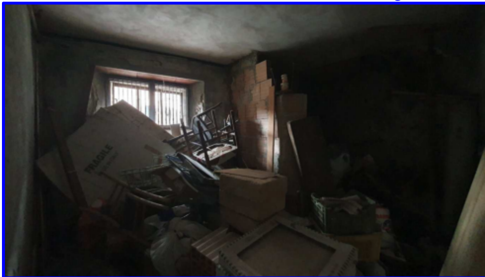
Particolare cantina con vista dall'ingresso verso la finestra
