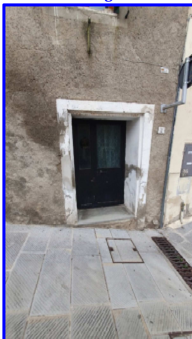
Vista dell'ingresso al piano seminterrato
