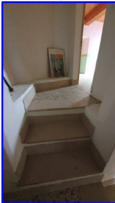
Particolare vano scale con vista verso il disimpegno e l'accesso alla camera n.1
