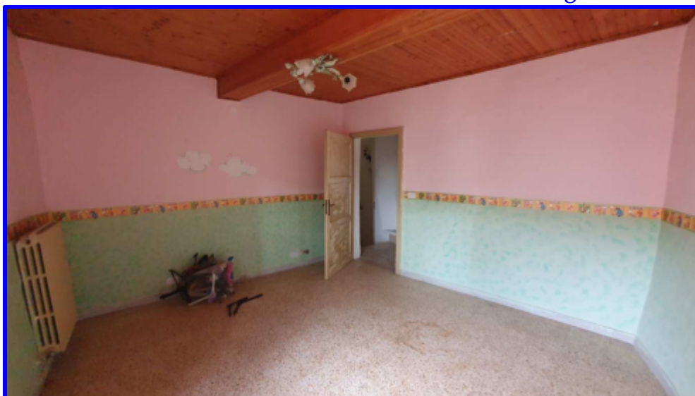
Particolare camera n.1 con vista verso la porta di accesso
