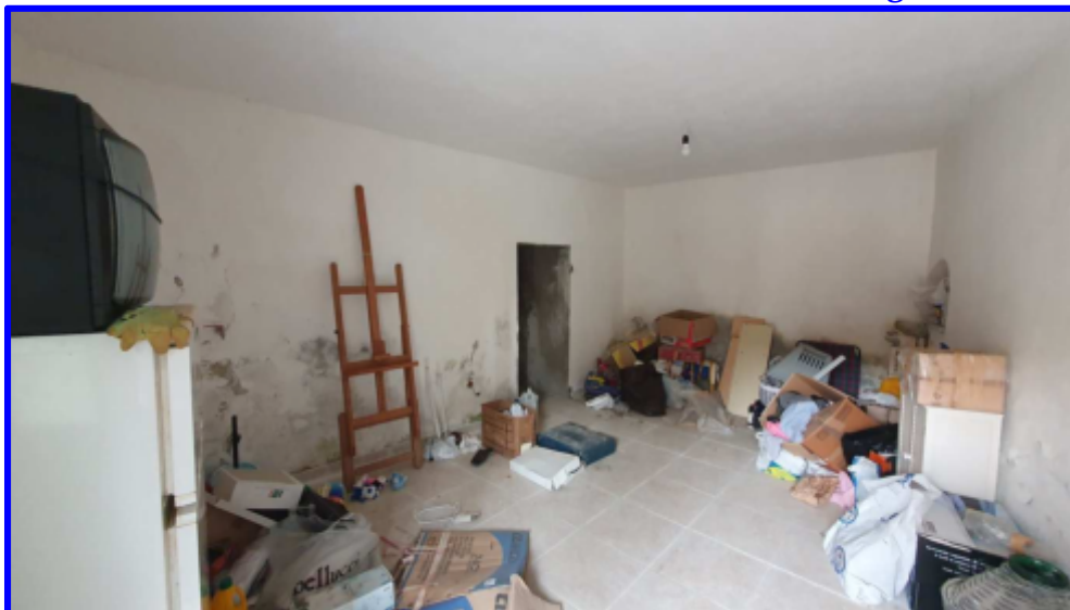
Particolare sgombero con vista dall'ingresso
