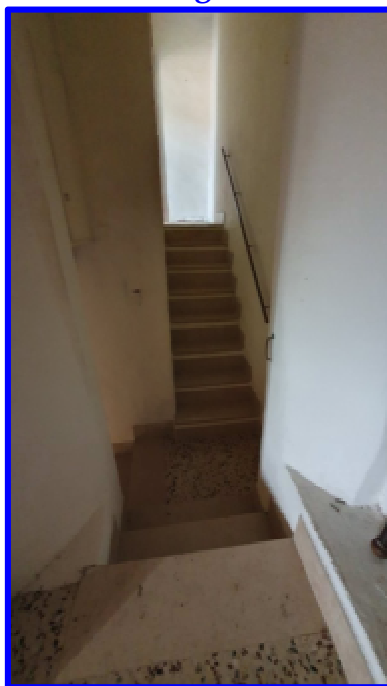
Particolare vano scale con vista dal disimpegno verso la rampa che conduce al bagno
