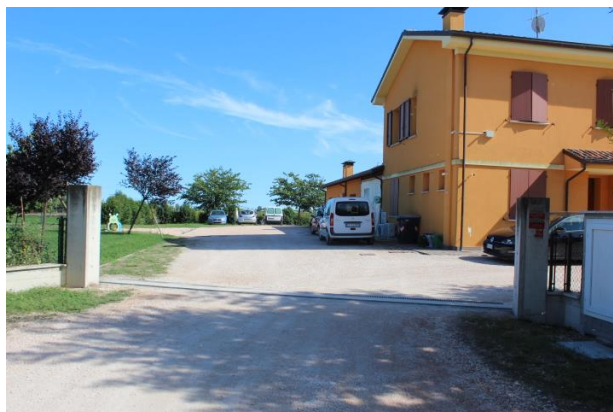
PARTICOLARE INGRESSO CARRABILE DALLA STRADA PUBBLICA A SERVIZIO DEI FABBRICATI E DEL TERRENO RETROSTANTE
