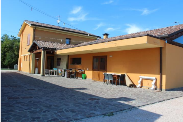
PARTICOLARE DA SUD-EST RISTORANTE E ABITAZIONE
