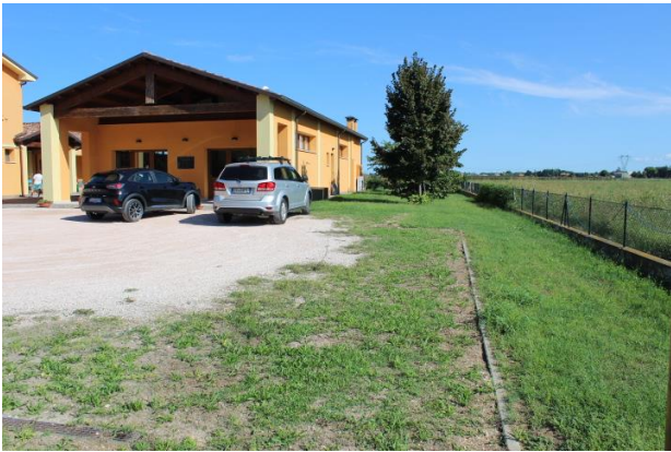
VISTA DA SUD-OVEST DEL CORPO ZONA VENDITA PRODOTTI, LABORATORIO E UFFICI CON PARTICOLARE DELLA RECINZIONE A SUD
