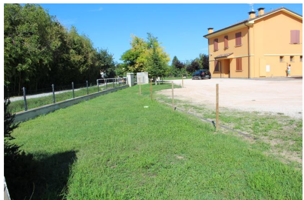
CORTE SUL FRONTE STRADA CON VISTA DELLA RECINZIONE
