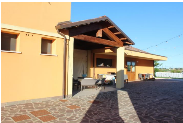
PARTICOLARE PORTICO DI COLLEGAMENTO FRA L'ABITAZIONE ED IL RISTORANTE
