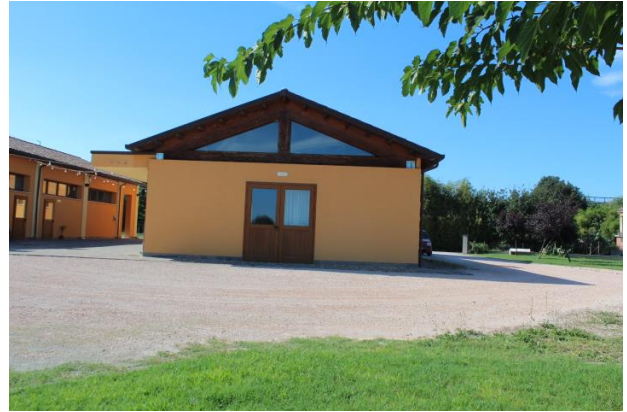
PARTICOLARE DEL RISTORANTE VISTO DA EST
