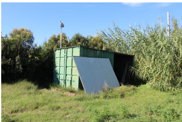
MANUFATTO ABUSIVO DA RIMUOVERE
