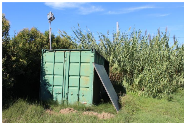
MANUFATTO ABUSIVO DA RIMUOVERE
