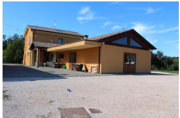
VISTA DA SUD-EST DEL RISTORANTE E DELL'ABITAZIONE
