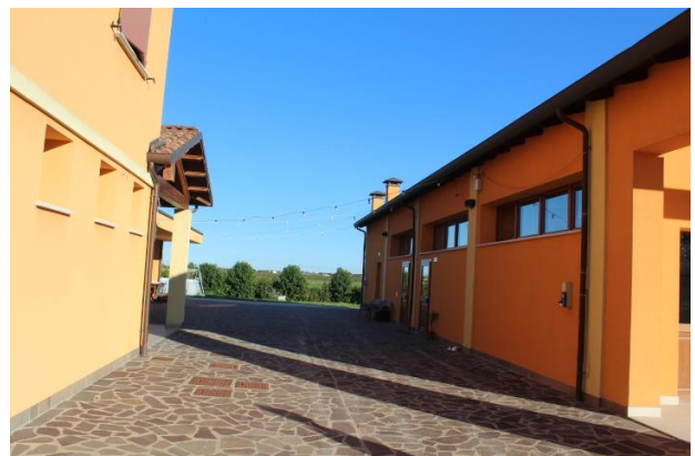
PARTICOLARE DELLA CORTE FRA I DUE CORPI DI FABBRICA, INTERAMENTE PAVIMENTATA
