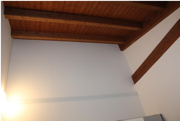
PARTICOLARE COPERTURA UFFICI
