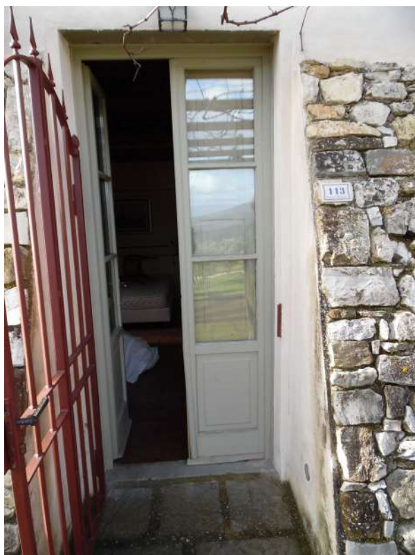
FOTO 19 – Vista ingresso camera (7)
