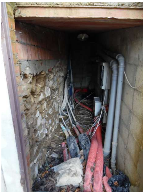
FOTO 9 – Vista vano tecnico
