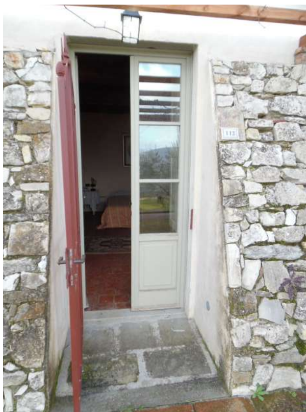
FOTO 15 – Vista ingresso camera (4)
