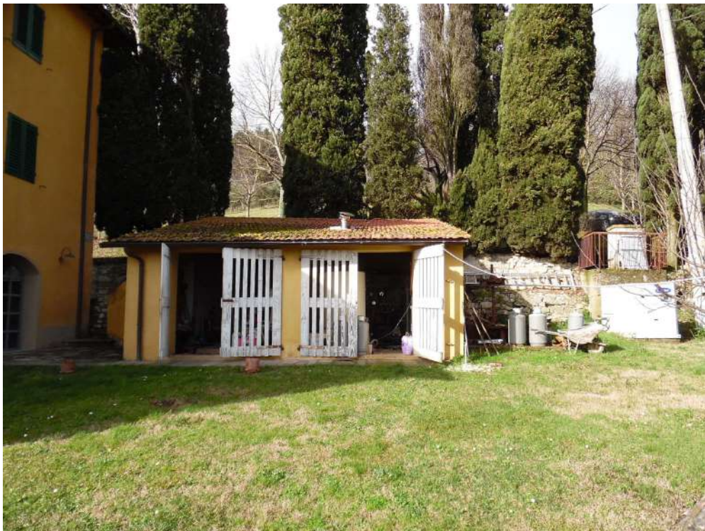
FOTO 38 – Vista rimessa/locale tecnico (15-16)
