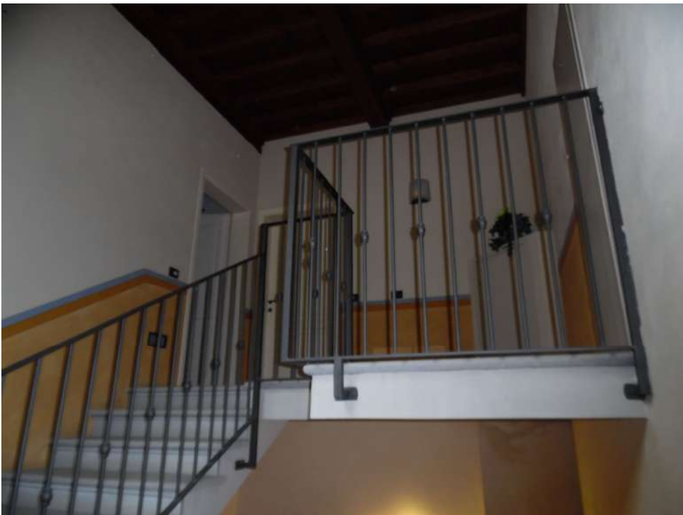
FOTO 8 – Vista vano scale (37)
