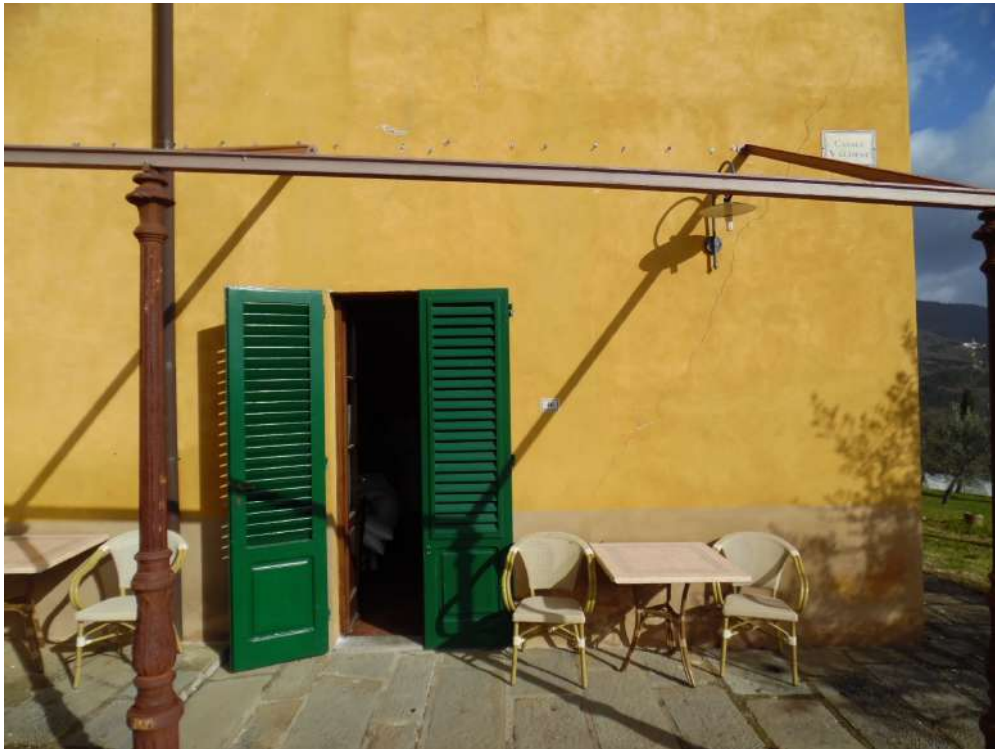
FOTO 39 – Vista ingresso camera (13)
