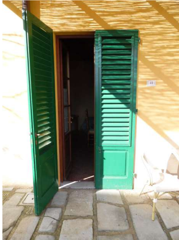
FOTO 45 – Vista ingresso camera (1)
