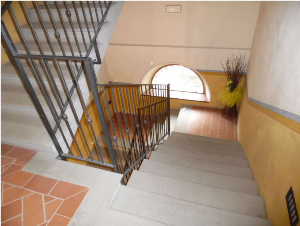
FOTO 33 – Vista vano scale (24)
