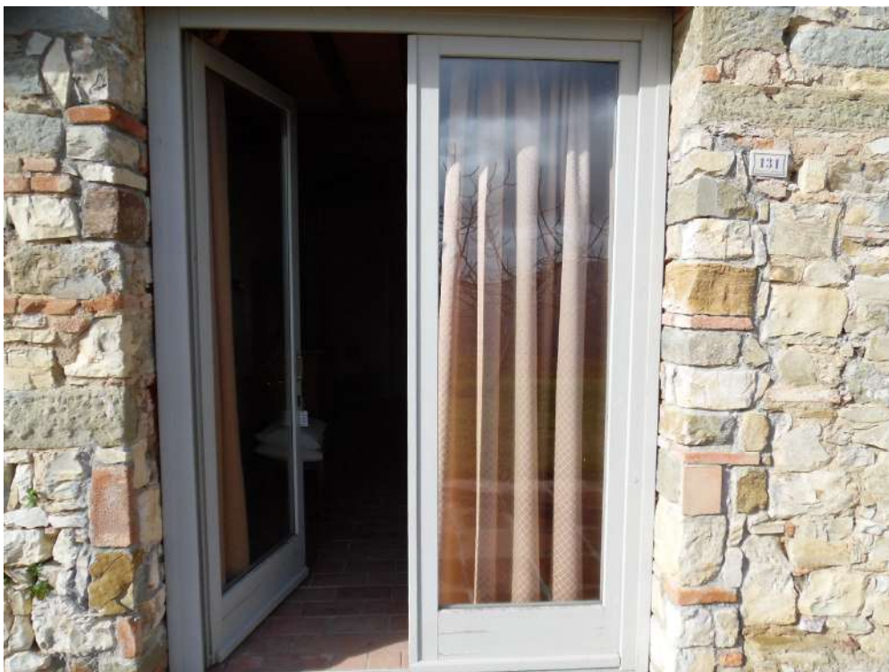
FOTO 50 – Vista ingresso camera (3)
