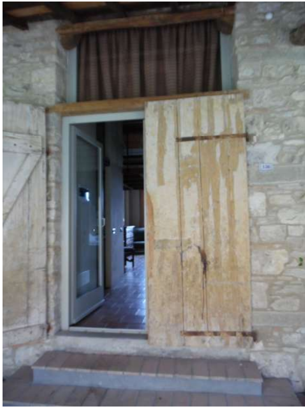
FOTO 25 – Vista ingresso camera (16)
