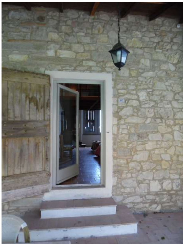
FOTO 19 –Vista ingresso camera (12)
