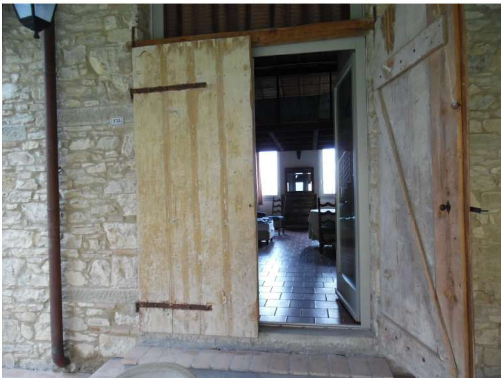
FOTO 33 – Vista ingresso camera (18)
