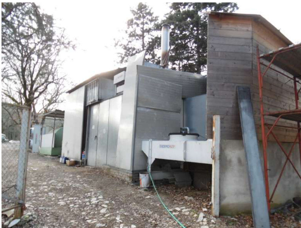
FOTO 26 – Vista esterna locale macchine
