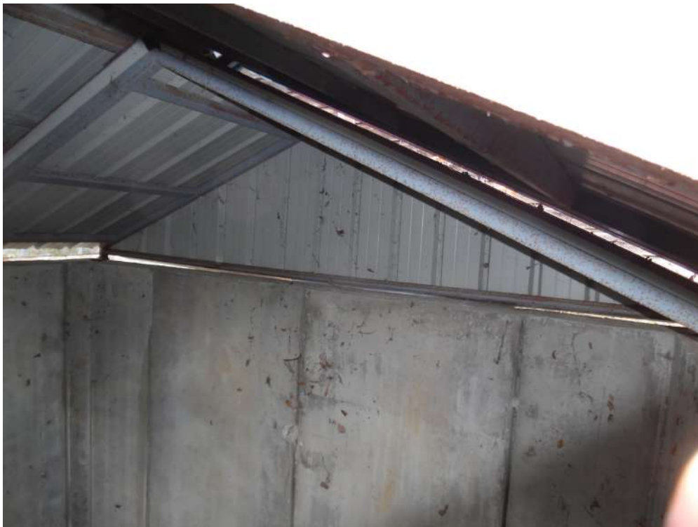
FOTO 16 – Vista silo orizzontale (1)
