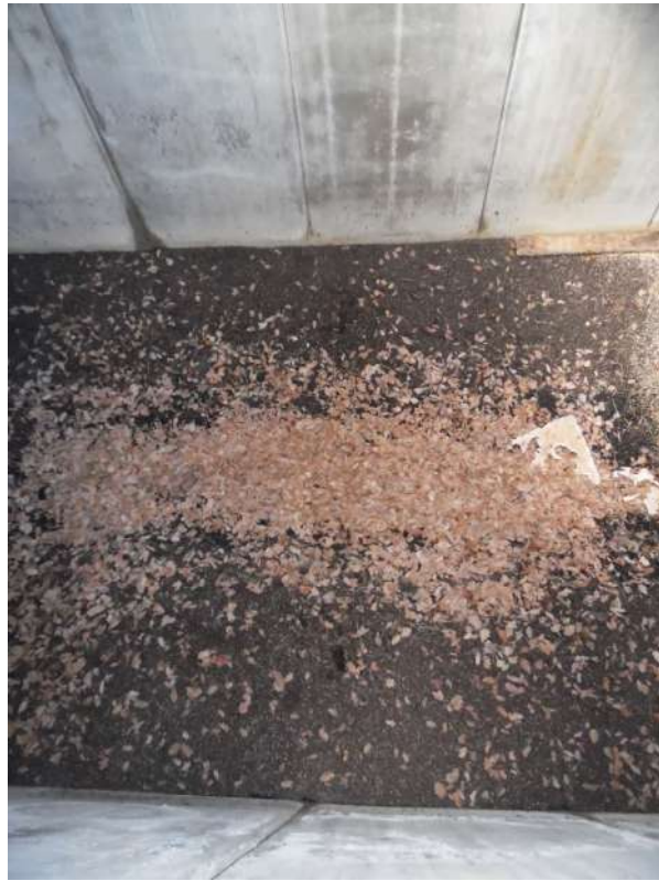
FOTO 15 – Vista silo orizzontale (1)
