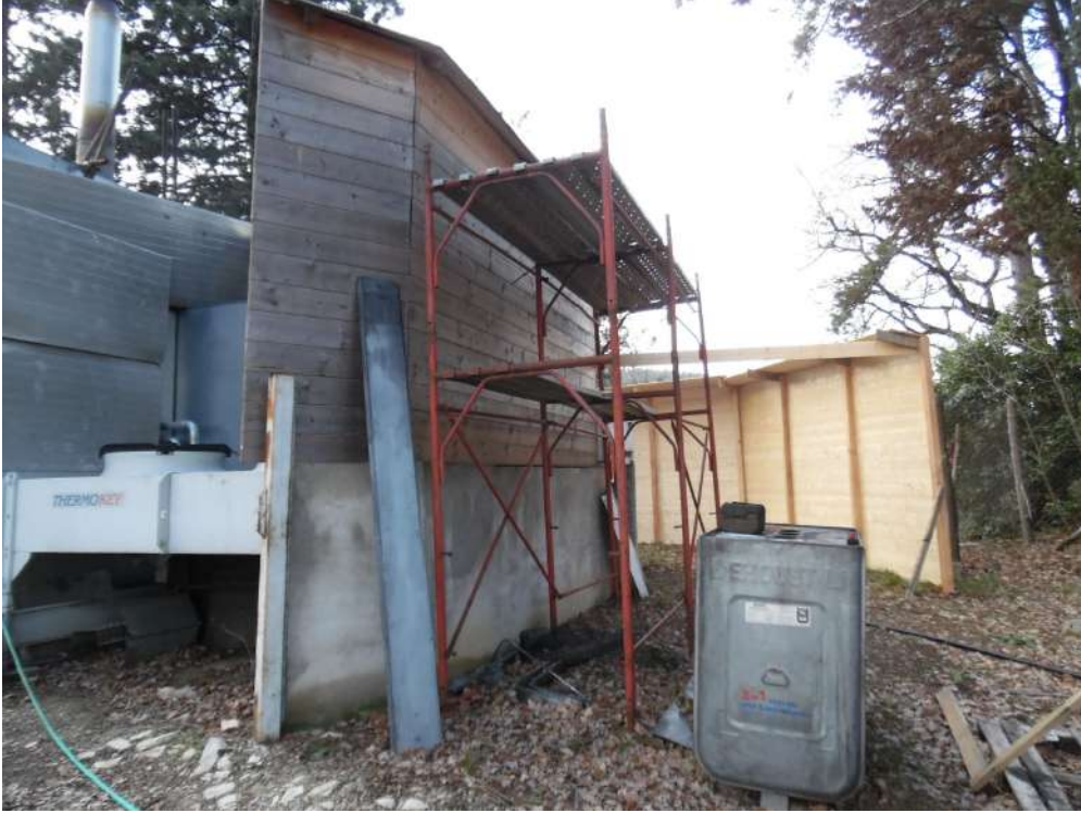
FOTO 27 – Vista esterna locale macchine
