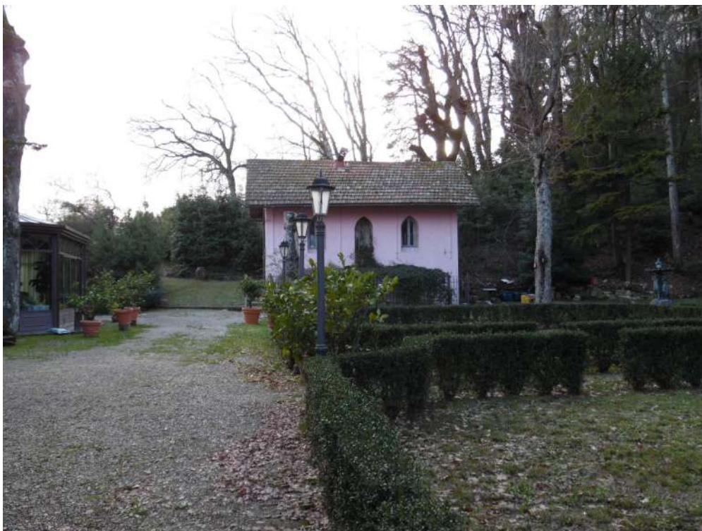
FOTO 147 – Vista esterna annesso
