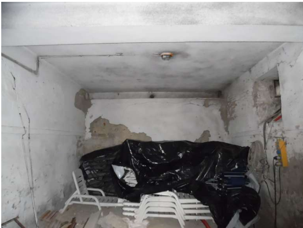
FOTO 136 – Vista scala ingresso camera (3)
