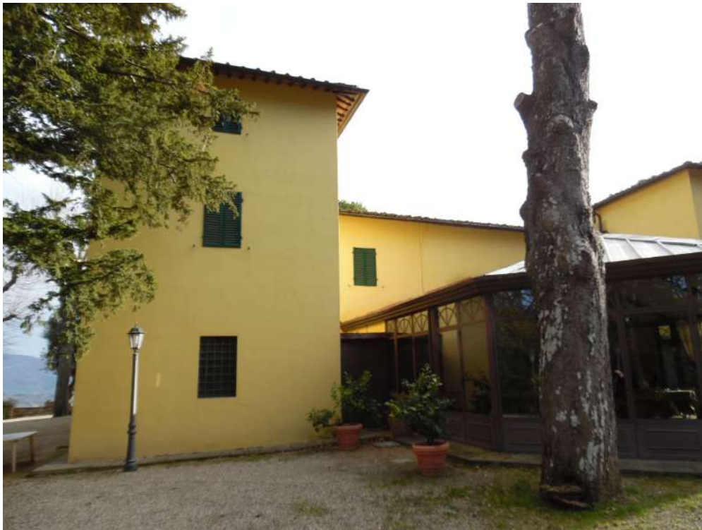
FOTO 140 – Vista posteriore villa
