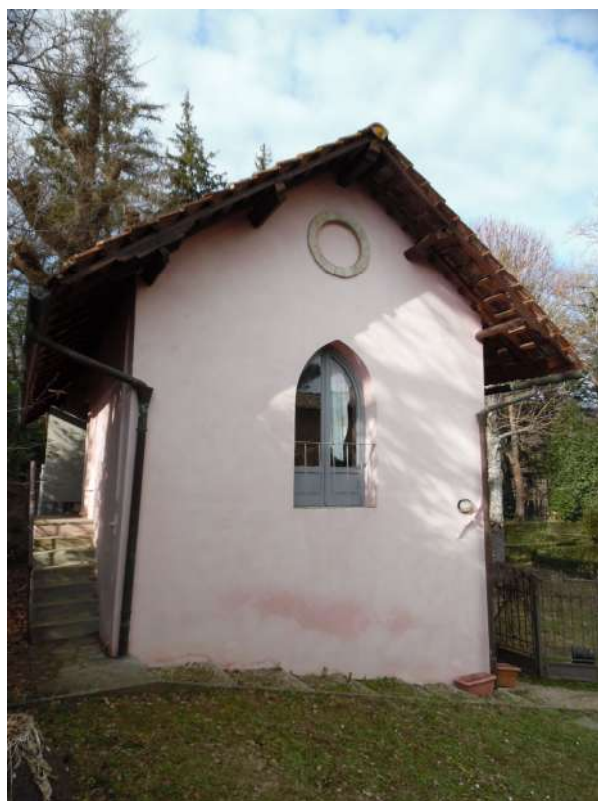
FOTO 149 – Vista esterna annesso
