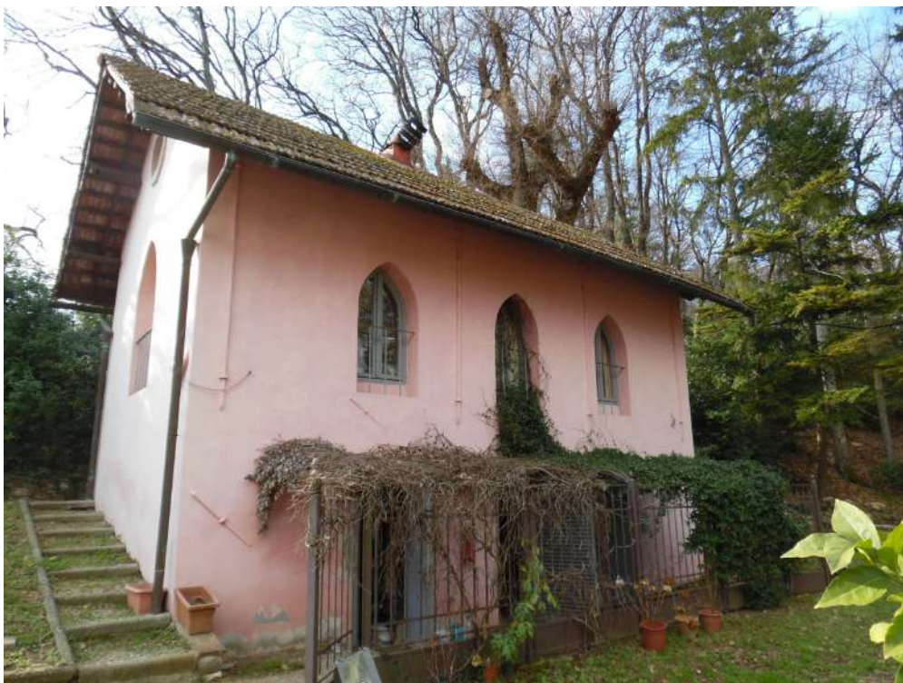
FOTO 148 – Vista esterna annesso
