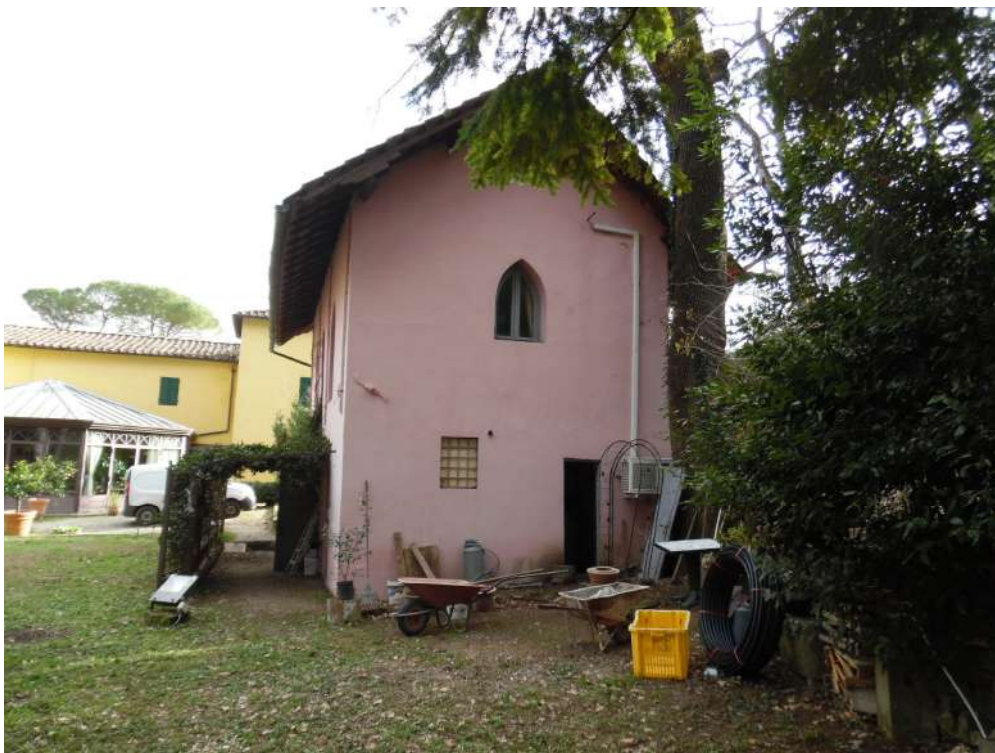
FOTO 151 – Vista esterna annesso
