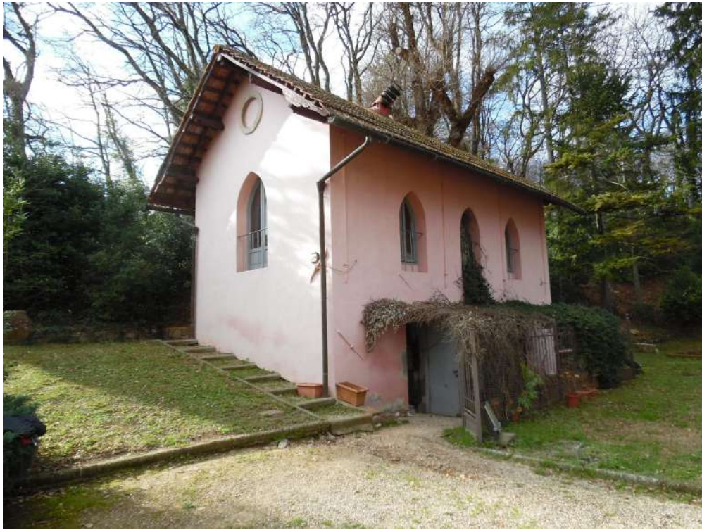
FOTO 152 – Vista esterna annesso
