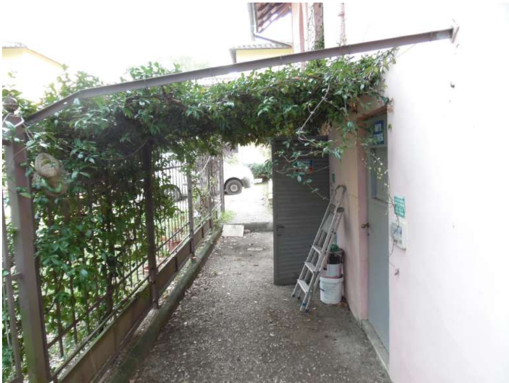
FOTO 153 – Vista scala ingresso camera (17)
