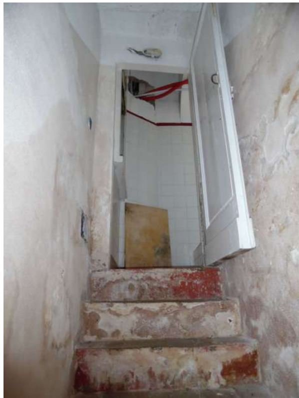
FOTO 60 – Vista scala di accesso cantina (1)
