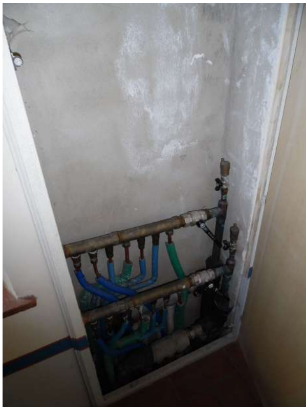
FOTO 38 – Vista vano impianti
