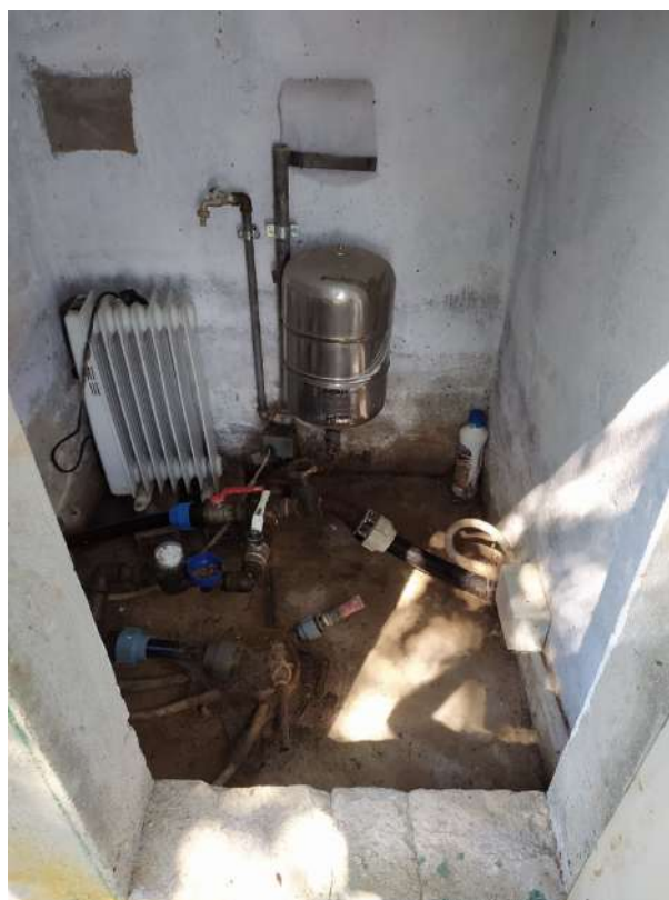
FOTO 21 – Vista interna pozzo
