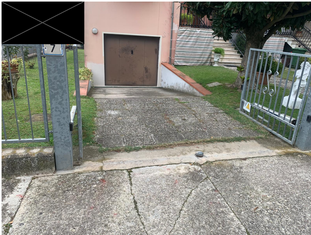
vista 3 ravvicinata accesso carraio fronte abitazione
