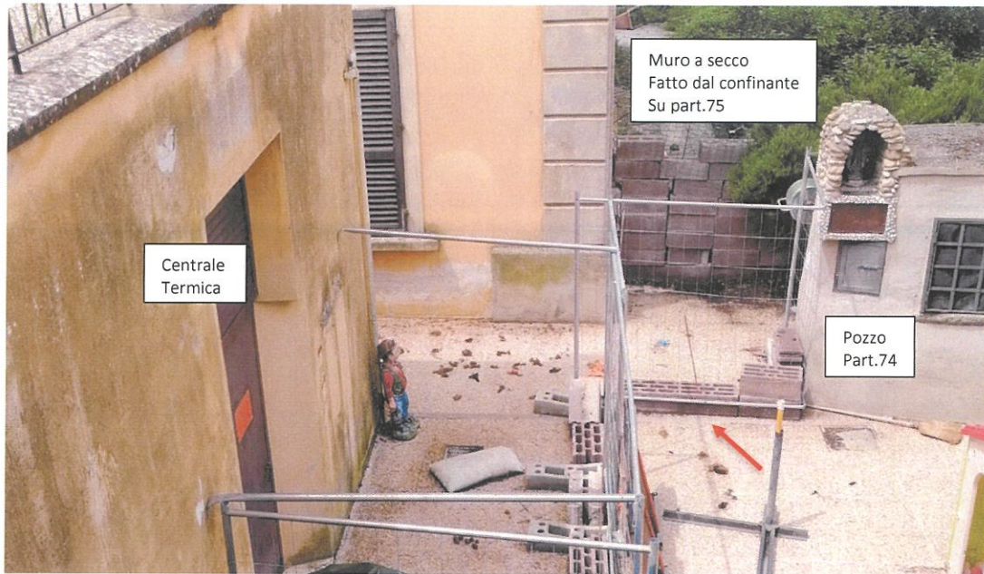
Foto n.5: Particolare dove si vede la fuga grossa sul pavimento davanti ai mattoni appoggiati sul pavimento
