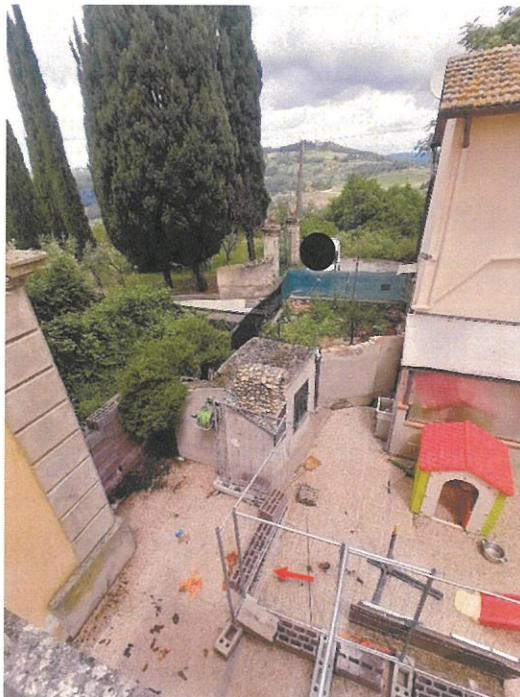
Foto n.3: confine tra part.75 e part.74 graffata – fuga grossa sul pavimento
