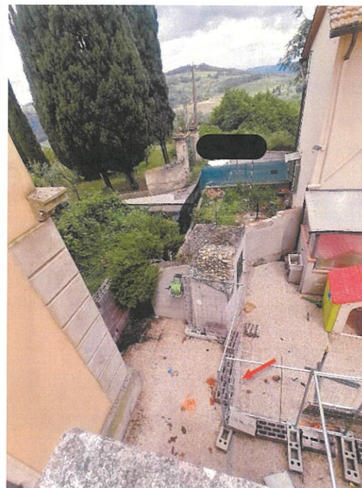
Foto n.4: confine tra part.75 e part.74 graffata – fuga grossa sul pavimento
