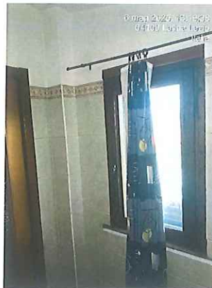
FOTOGRAFIA 21 - INTERNO P.1° BAGNO 2
