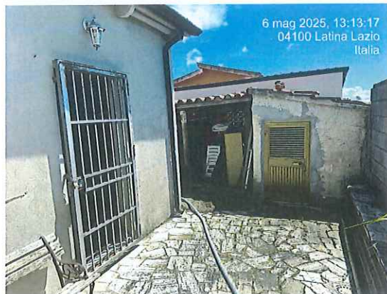
FOTOGRAFIA 6 - ESTERNO CORTE + LOCALE TECNICO/TETTOIA
