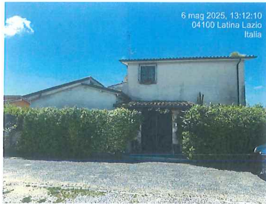
FOTOGRAFIA 3 - ESTERNO INGRESSO IMMOBILE
