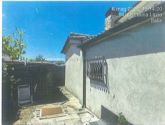
FOTOGRAFIA 7 - ESTERNO CORTE + LOCALE TECNICO/TETTOIA
