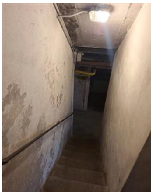
scala di accesso alle cantine
