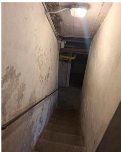
scala di accesso all'interrato, alle cantine
