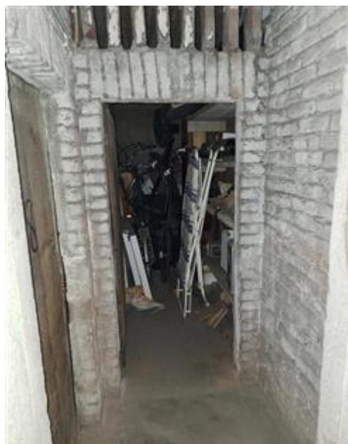
accesso alla cantina n. 9, rientrato nel corridoio
