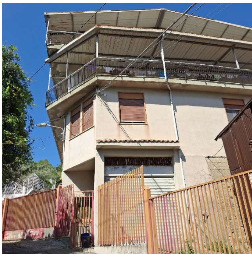
Fabbricato fg. 131 part. 1363 – Recinzione e ingresso
