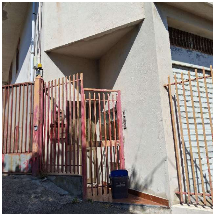
Ingresso al fabbricato
