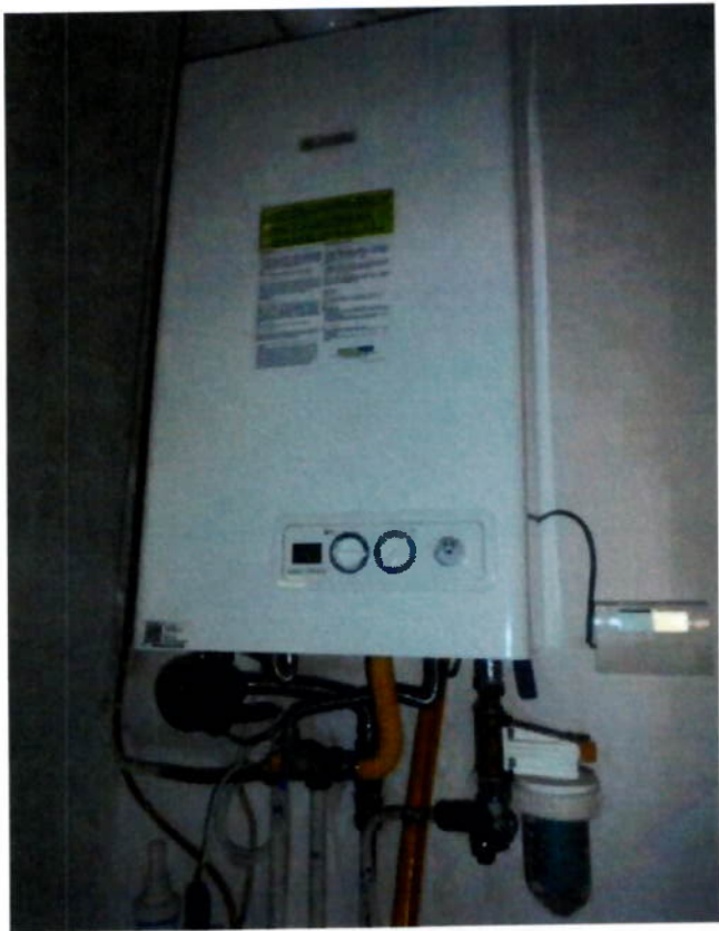
la calderina con un artigianale sistema di scarico condensa
