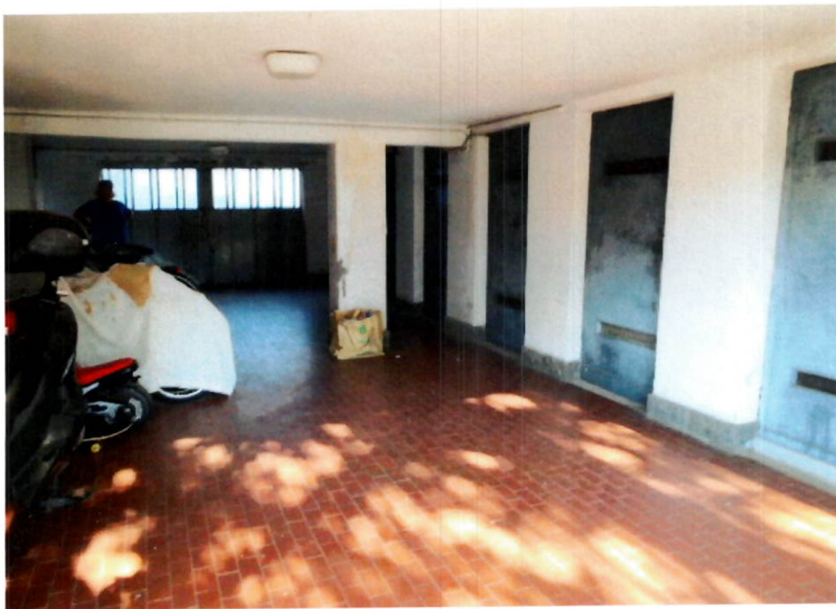
il porticato di ingresso delle cantine a piano terreno
