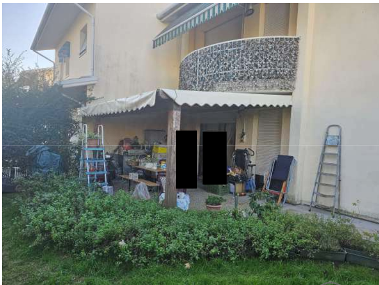
Lato nord - est
