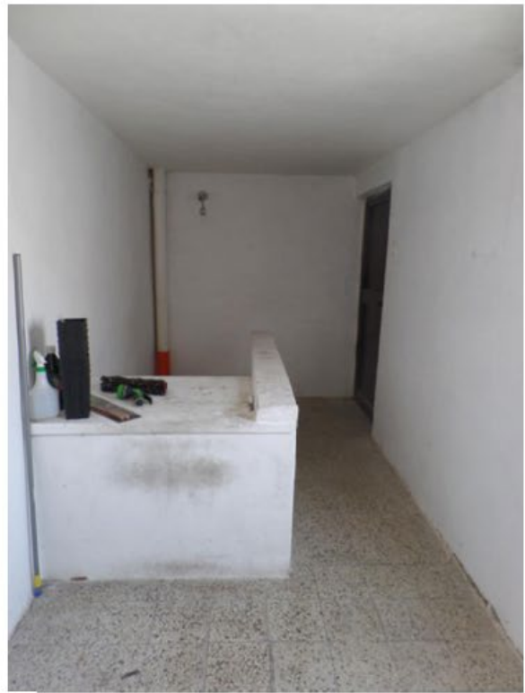
Foto n° 16. P. 2°. Vano Scala
