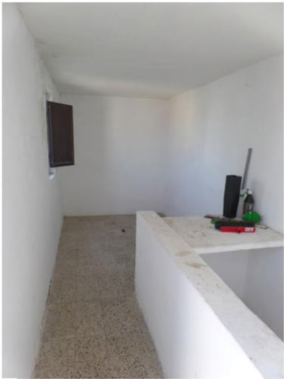
Foto n° 15. P. 2°. Vano Scala
