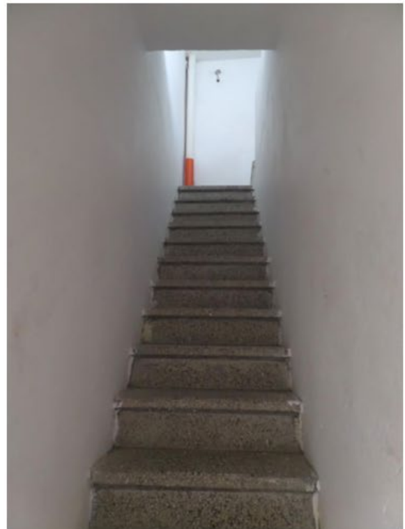
Foto n° 12. Scala P. 1° - P. 2°
