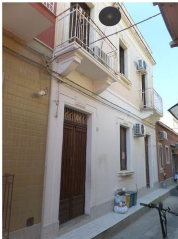
Foto n° 2. Traversa VIII di Corso Garibaldi n° 23
