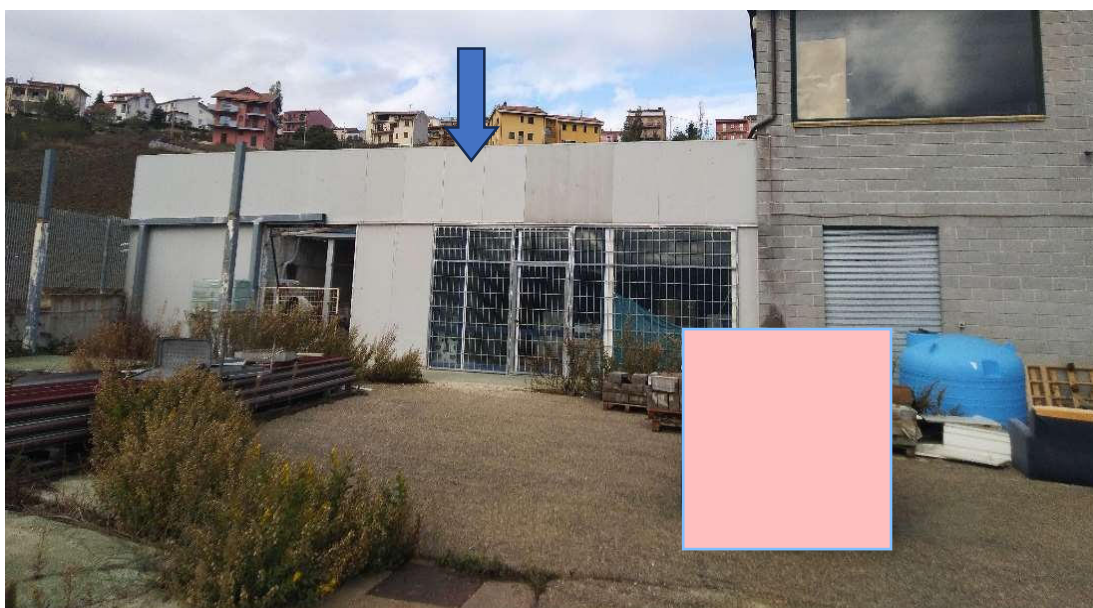
RIF. 2 TAB. 1 - DEPOSITO VISTA LATO ESTERNO
