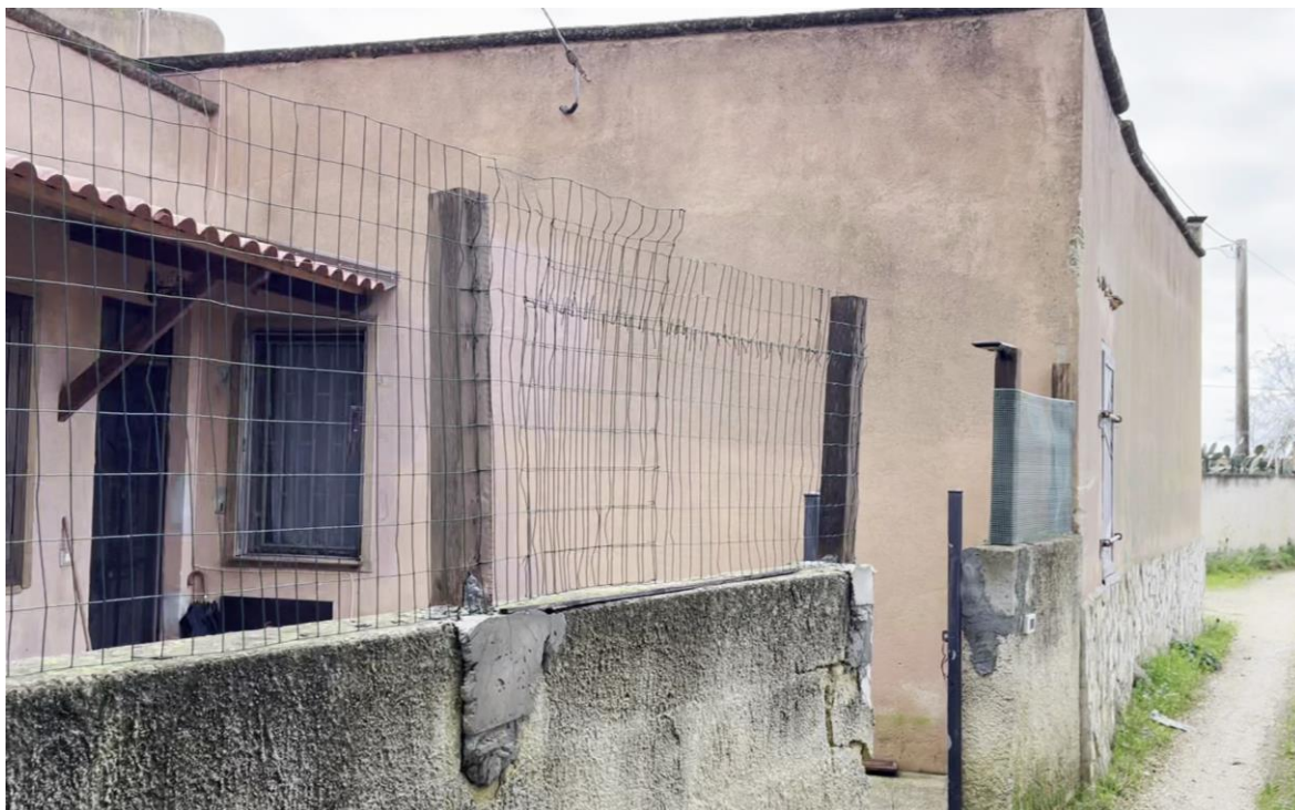
FOTO 9 - Cannello pedonale di accesso
