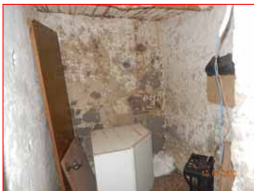
Foto n. 3 – interno locale di sgombero
