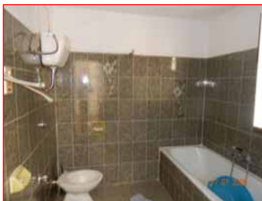
Foto n. 6 – bagno al primo piano
