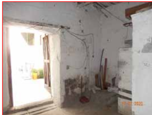
Foto n. 4 – locale di sgombero
