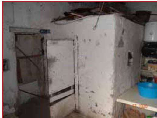
Foto n. 2 – locale di sgombero
