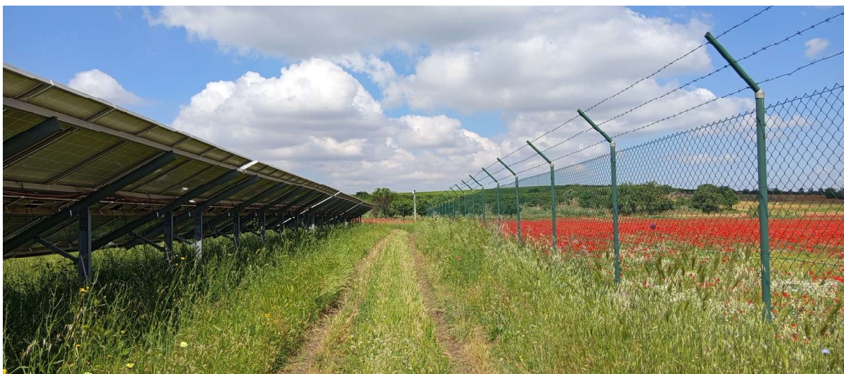
Vista della recinzione metallica a vista
