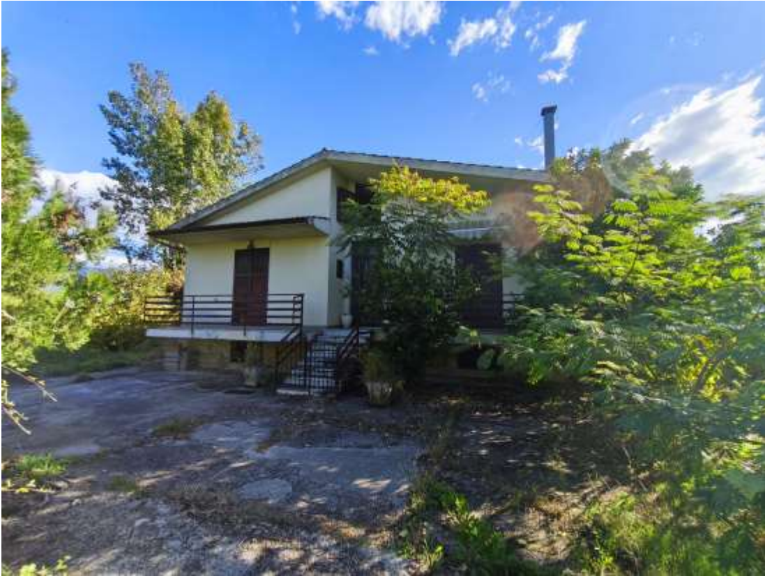
VISTA DEL FABBRICATO
