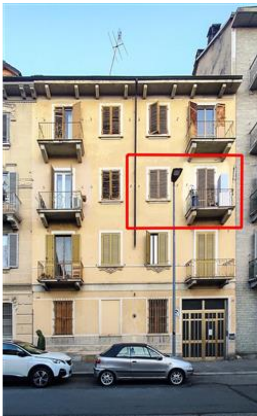
Facciata su via Fossata con indicazione unità oggetto di pignoramento
