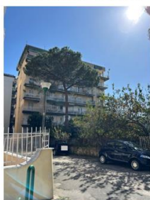
Foto n. 4 - Parco Verde - Palazzo il Tiglio
