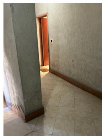
Foto n. 13 - Parco Verde - Palazzo il Tiglio - vano scale
