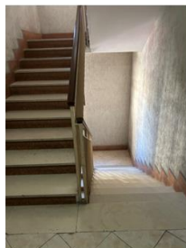
Foto n. 12 - Parco Verde - Palazzo il Tiglio - vano scale
