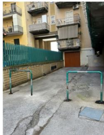
Foto n. 5 - Parco Verde - Palazzo il Tiglio
