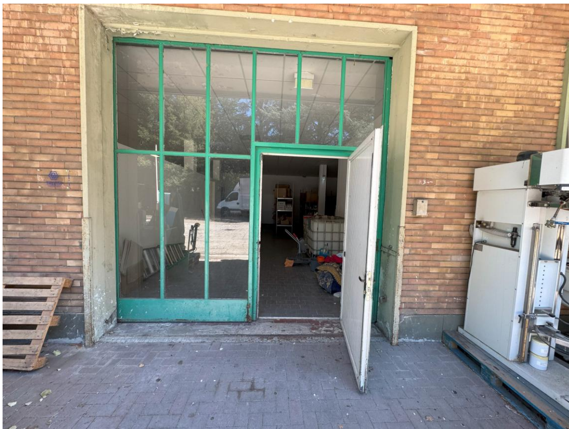
Immobile al piano terra – foto 1
