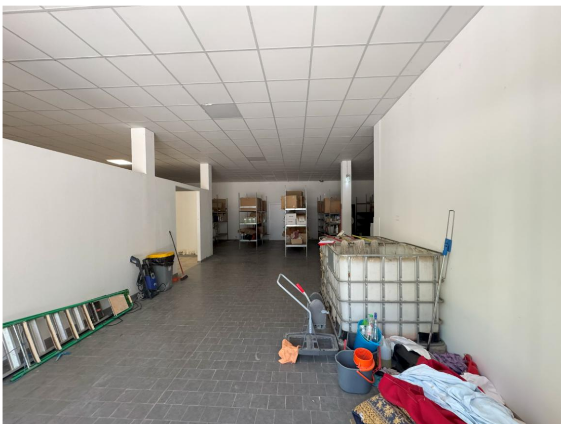
Immobile al piano terra – foto 2
