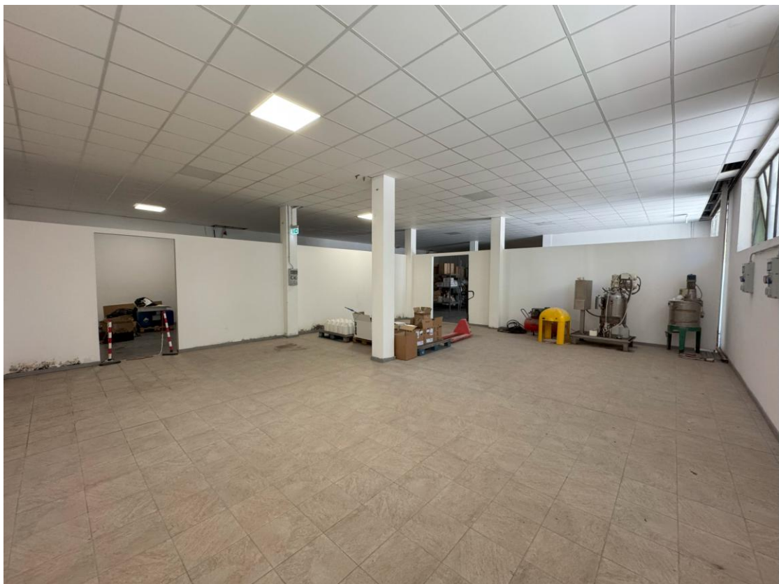
Immobile al piano terra – foto 4
