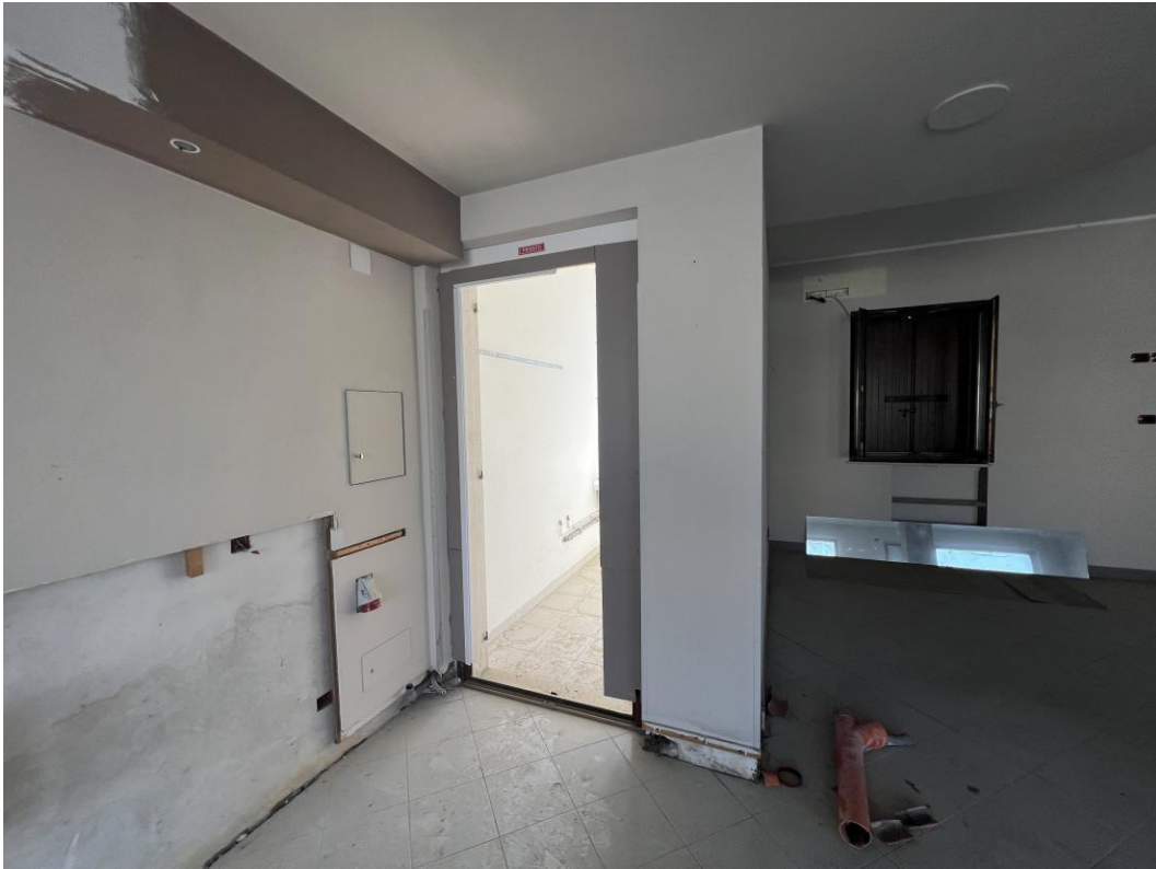
ACESSO AL RIPOSTIGLIO
