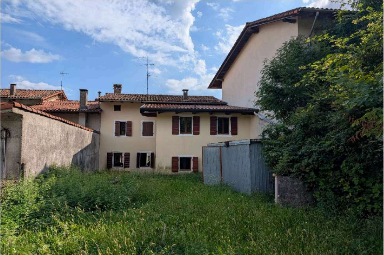
Foto n. 5 – Vista sull'edificio dall'area scoperta verso Sud.
