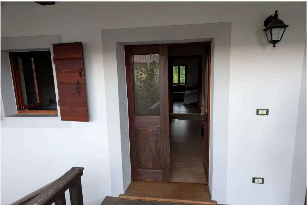
Foto n. 26 – Accesso principale dal ballatoio al piano primo.
