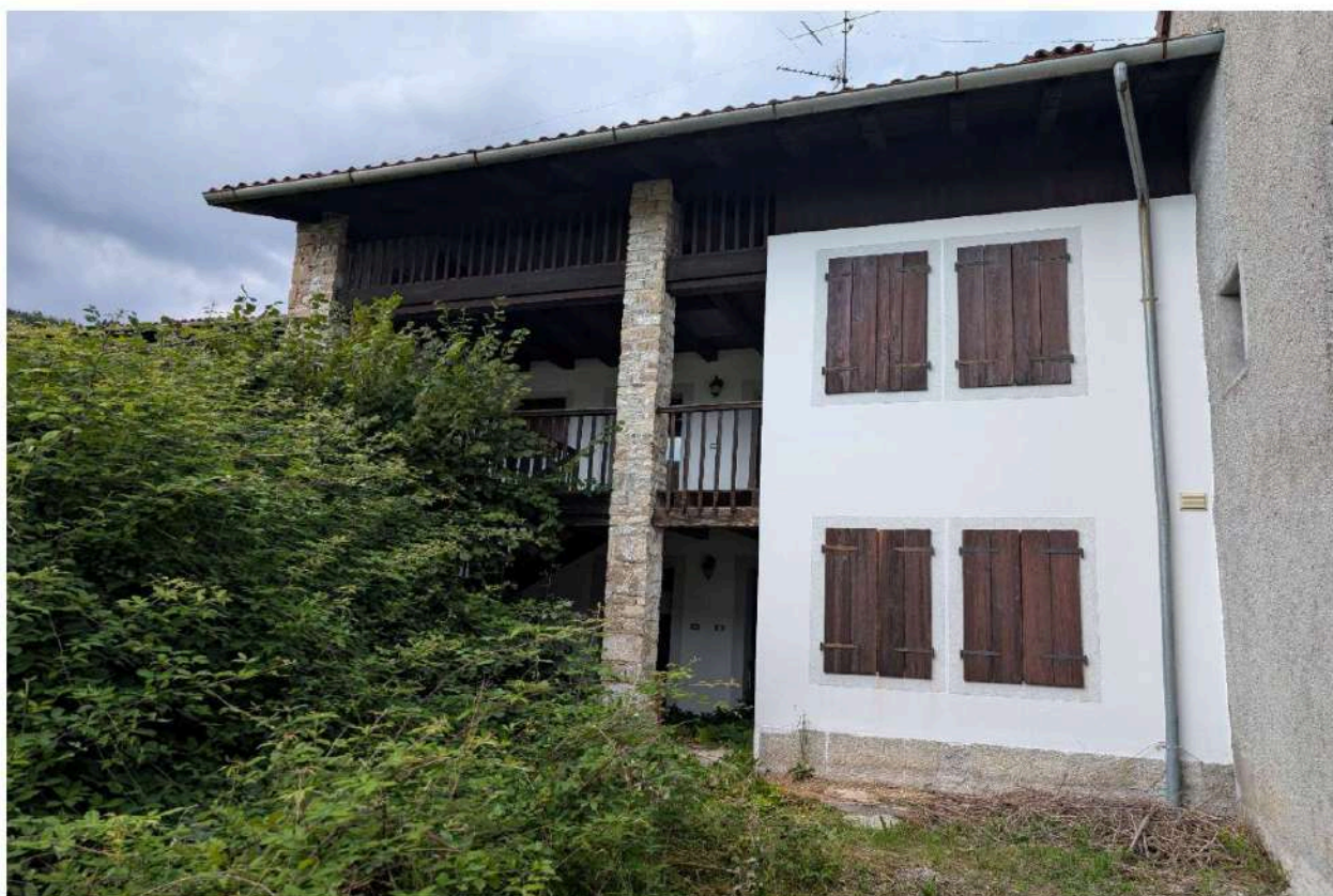
Foto n. 4 – Edificio visto dall'area scoperta lato strada.
