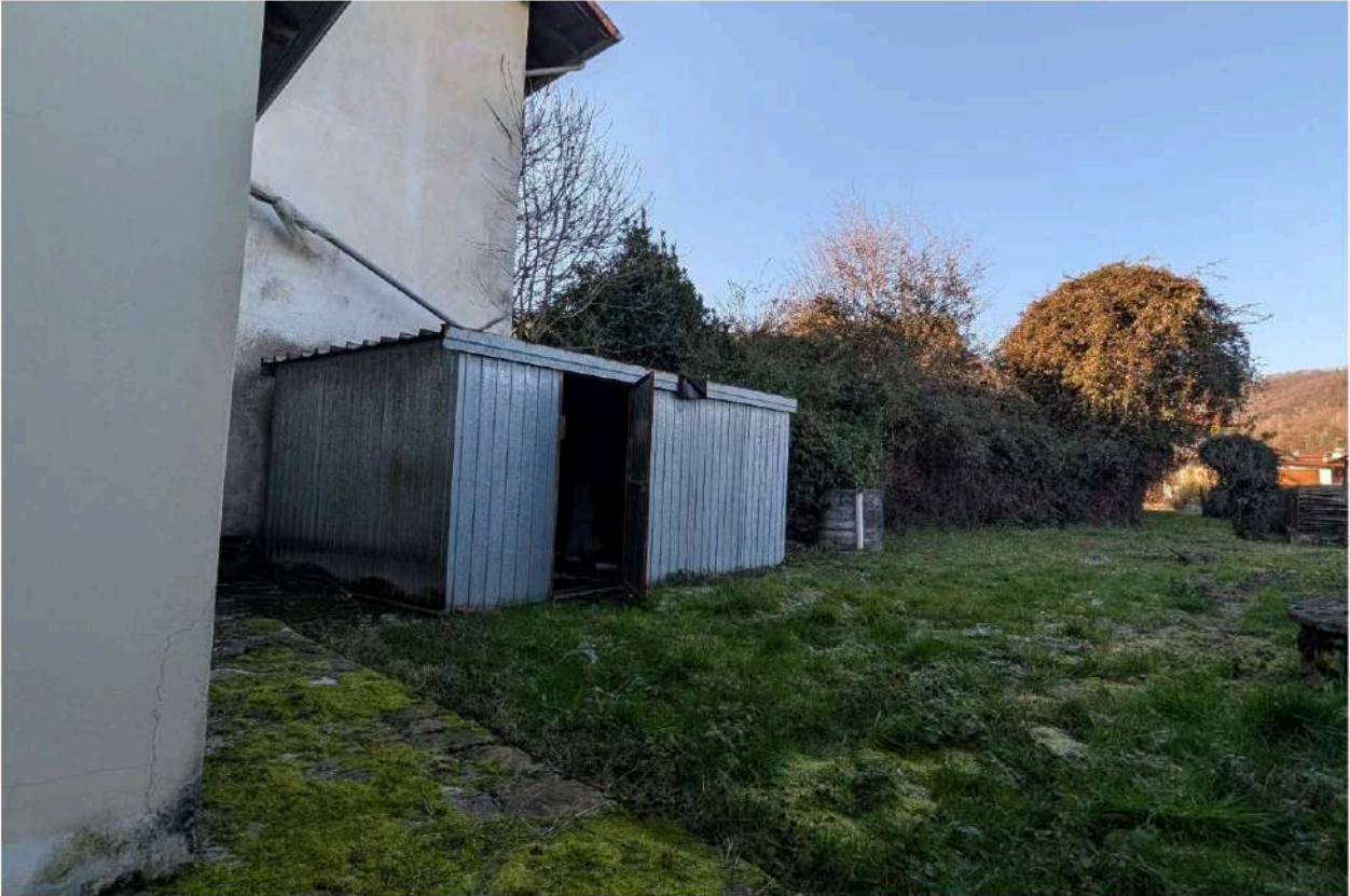
Foto n. 37 – Box in lamiera, sprovvisto di titoli autorizzativi.
