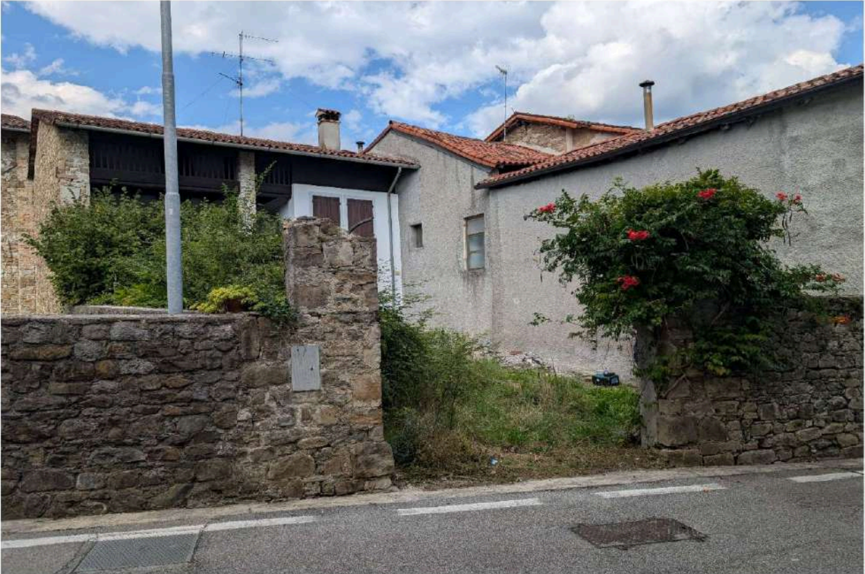
Foto n. 1 – Immobile visto da via Toffoli.
