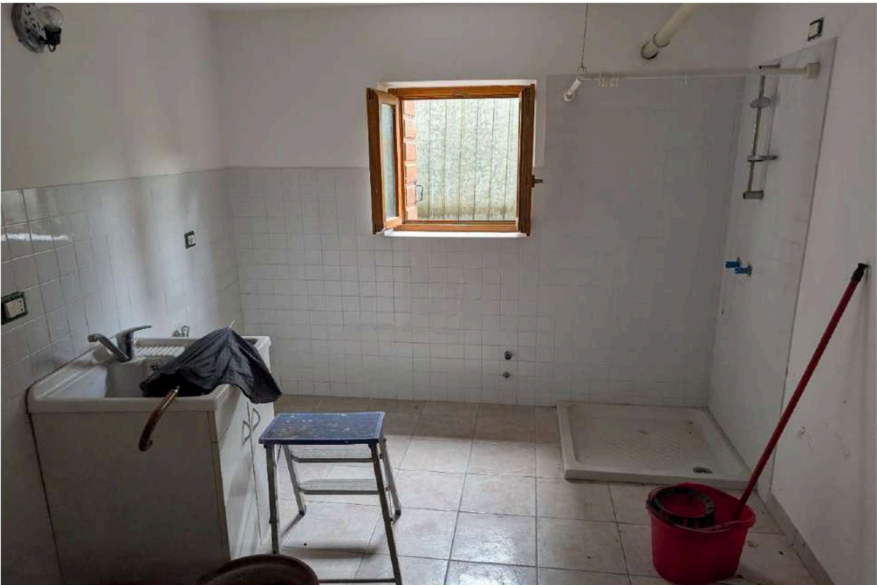
Foto n. 22 – Lavanderia – Centrale termica.
