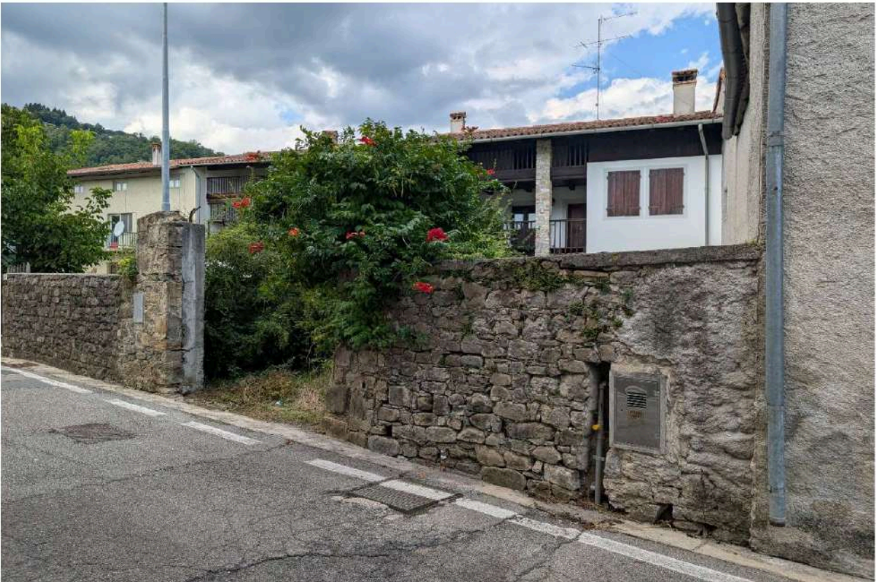
Foto n. 2 – Immobile visto da via Toffoli.
