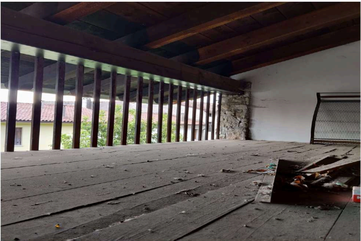
Foto n. 34 – Soppalco del sottotetto non abitabile.
