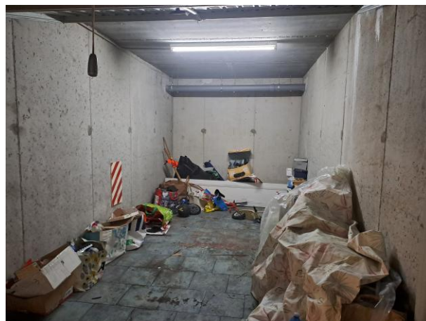
Vista dell'autorimessa di cui al sub. 17
