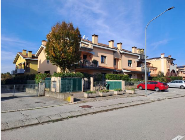
Vista generale da Sud-Est
