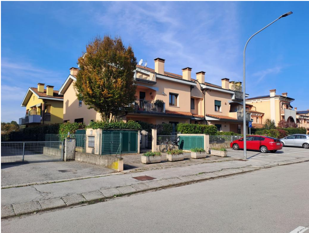
1. Vista generale da Sud-Est
