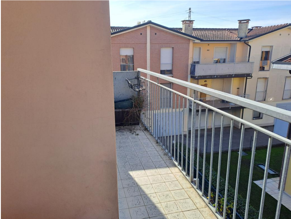
19. Vista della terrazza a servizio della camera da letto padronale
