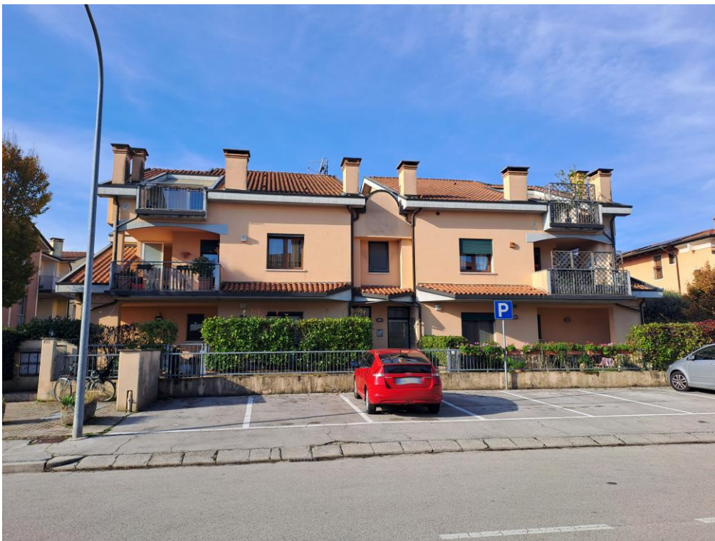
2. Vista generale da Est
