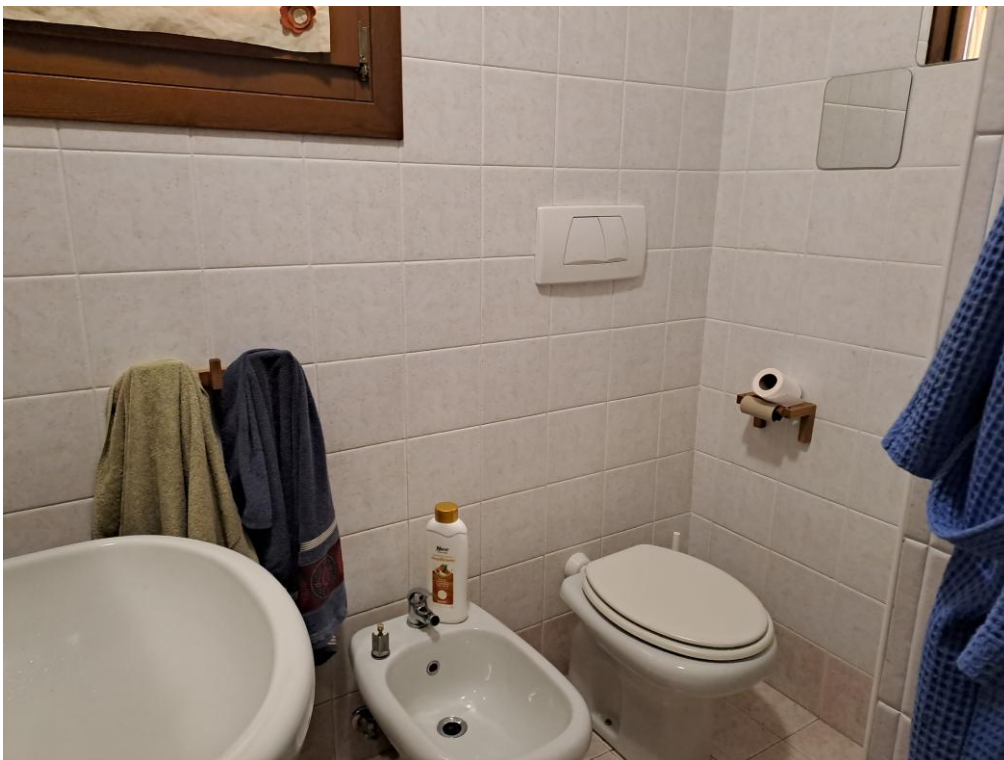
10. Vista del servizio igienico al piano primo
