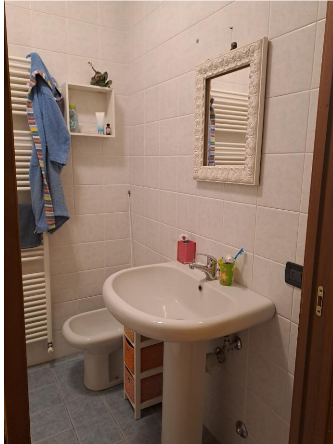
21. Vista del servizio igienico al piano secondo
