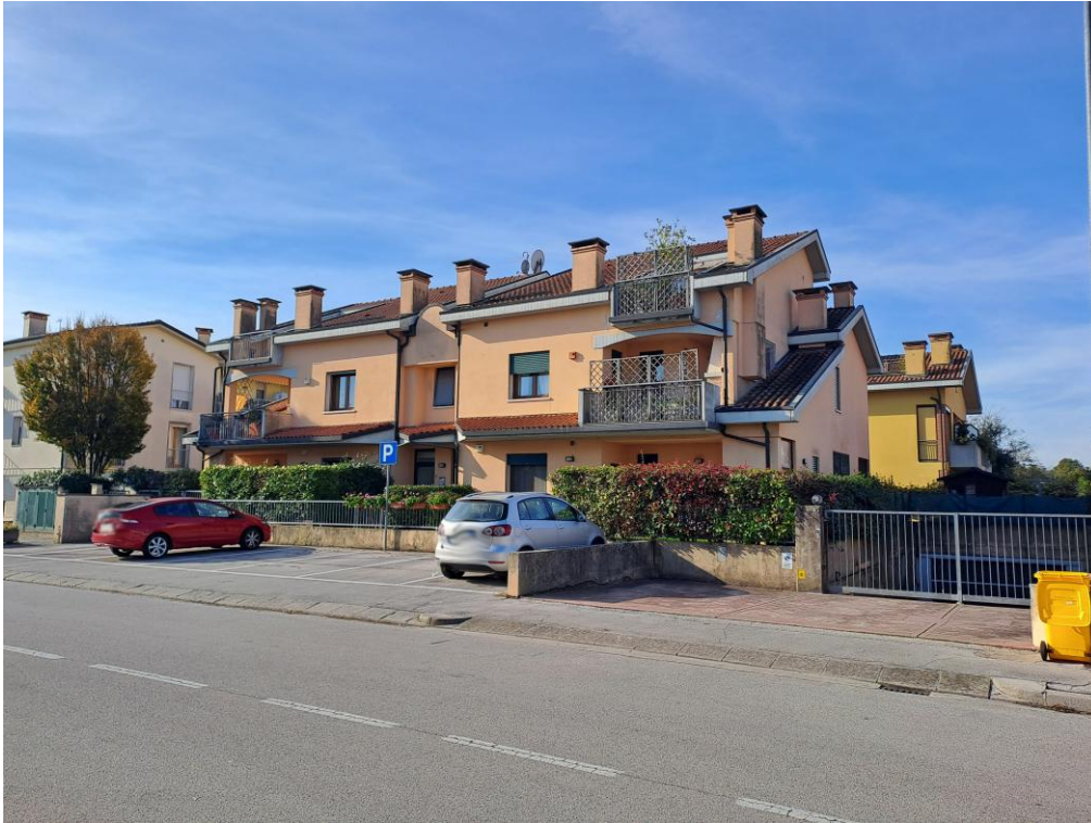
3. Vista generale da Nord-Est
