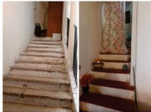
CTU ESECUZIONE IMMOBILIARE N°14/2024 R.G.E. TRIBUNALE DI CASTROVILLARI - SCALA INGRESSO PRINCIPALE APPARTAMENTO AL PIANO 2° ED INGRESSO SUPERIORE DA VIA F. POMETTI
