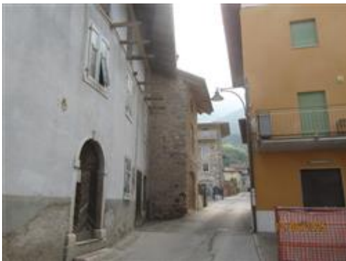
VISTA EDIFICIO LATO VIA NUOVA
