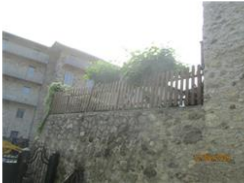
VISTA CORTILE EDIFICIO LATO NORD
