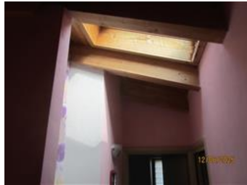
finestra in falda
