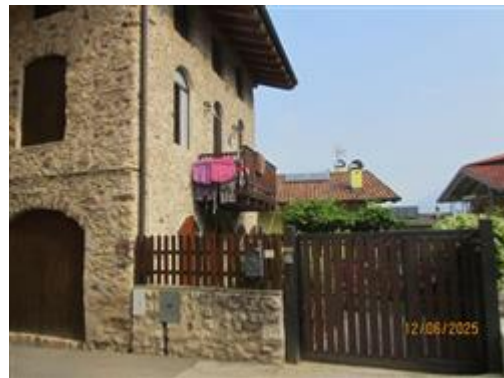
VISTA EDIFICIO LATO VIA NUOVA
