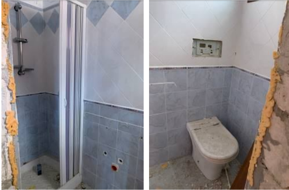
FOTO 10-11 Bagno Piano Primo
