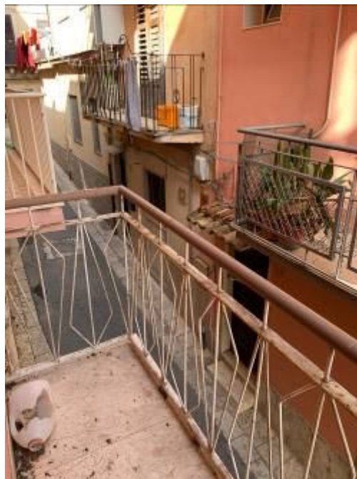
FOTO 12 Balcone Piano Primo
