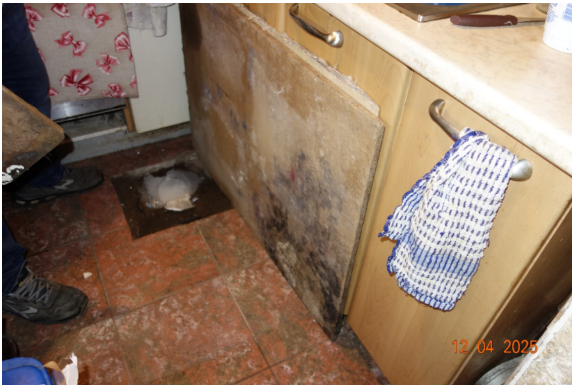
Foto 16 Posizione del pozzo all'interno del cucinino a quota 0,00
