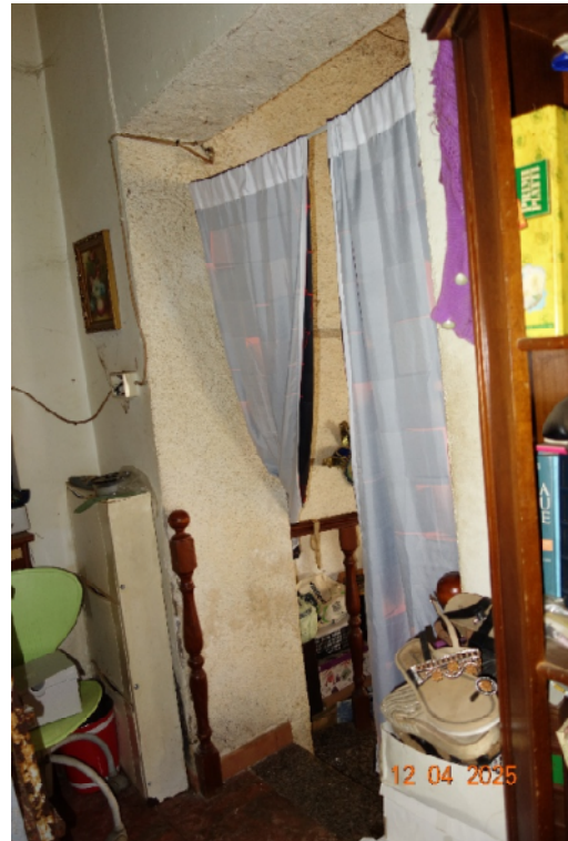
Foto 22 Vista dal disimpegno verso il vano di ingresso
