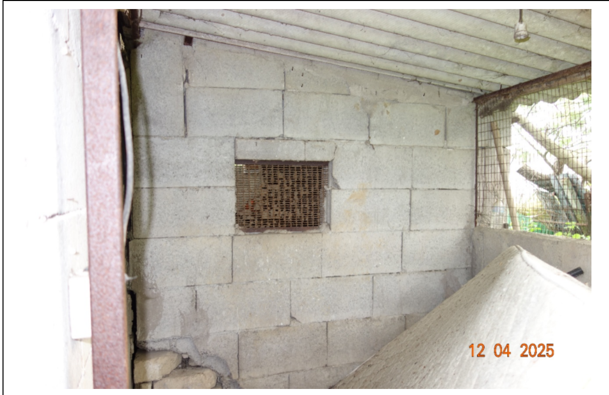
Foto 36 Tettoia posta sul retro del magazzino
