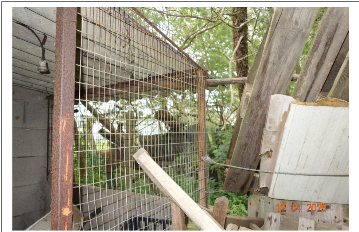
Foto 37 Tettoia posta sul retro del magazzino
