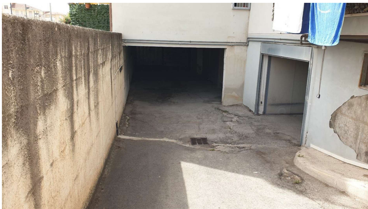
INGRESSO GARAGE (piano interrato)
