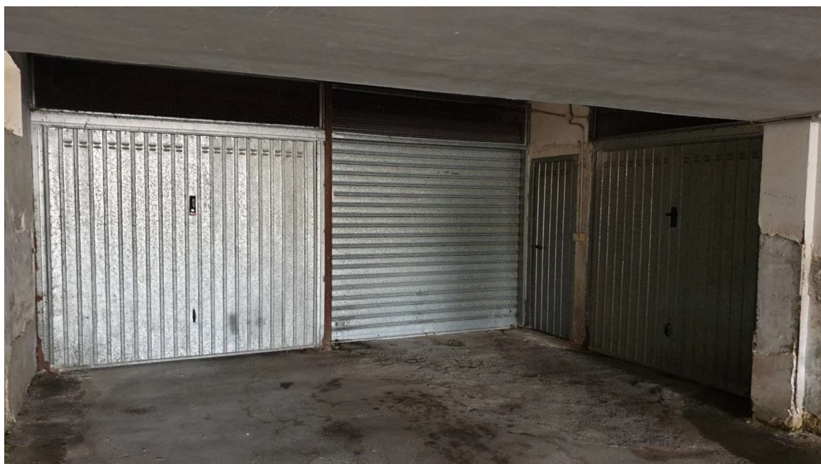
GARAGE (piano interrato)
