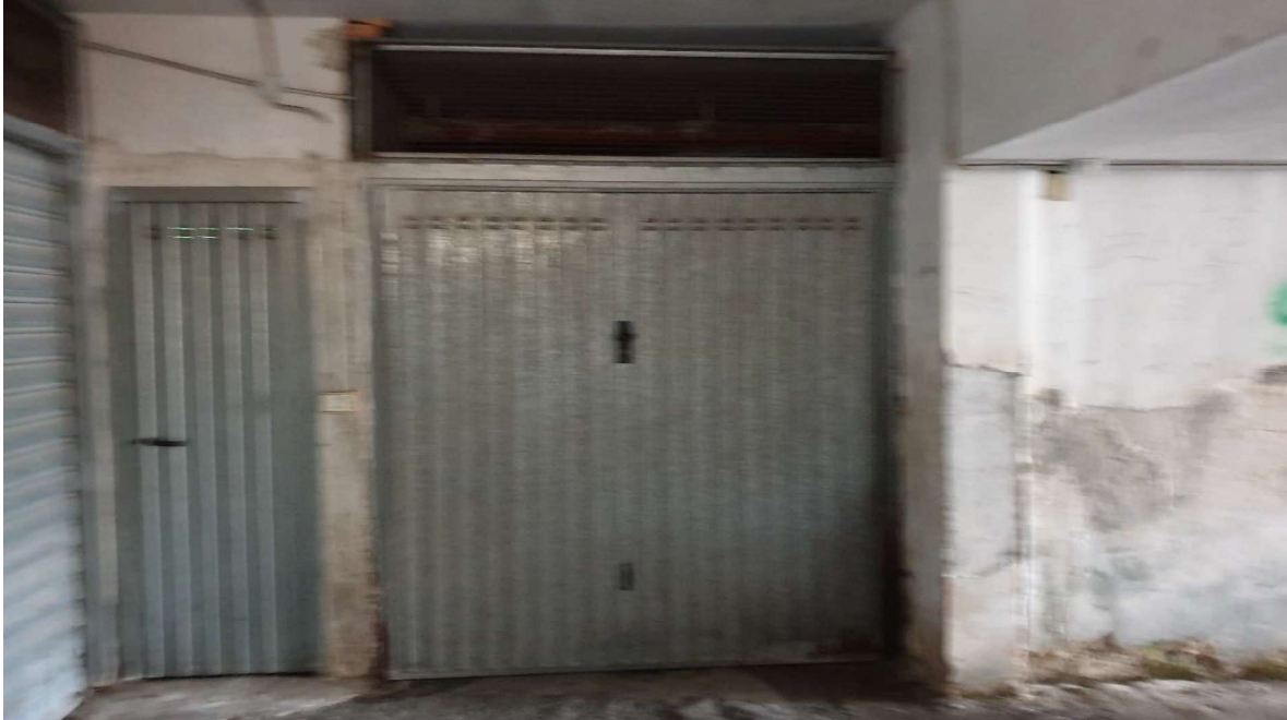
GARAGE (piano interrato)
