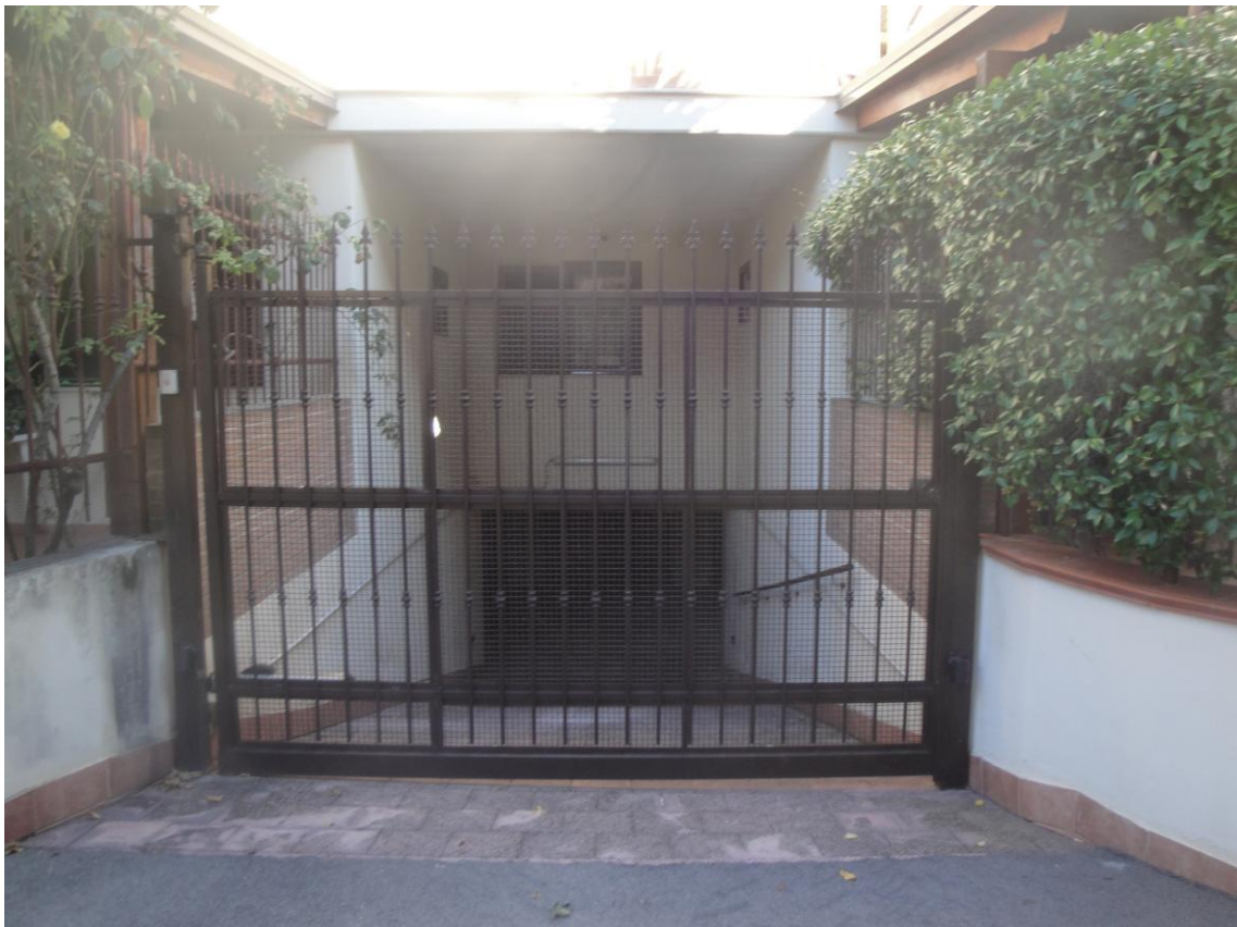
Foto 18: LOTTO 1. Immobile B. Box sito Cerignola (FG), alla Via dei Tulipani snc, piano S1, interno 9. Rampa di accesso all'autorimessa al piano S1.
