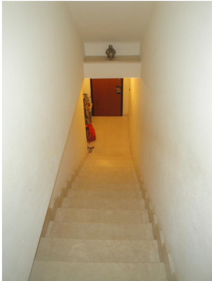
Foto 1: LOTTO 3. Immobile E. Appartamento sito in Cerignola (FG), alla Via dei Tulipani snc, piano T-1-2. Vano scala di collegamento del P.T. al P.1.
