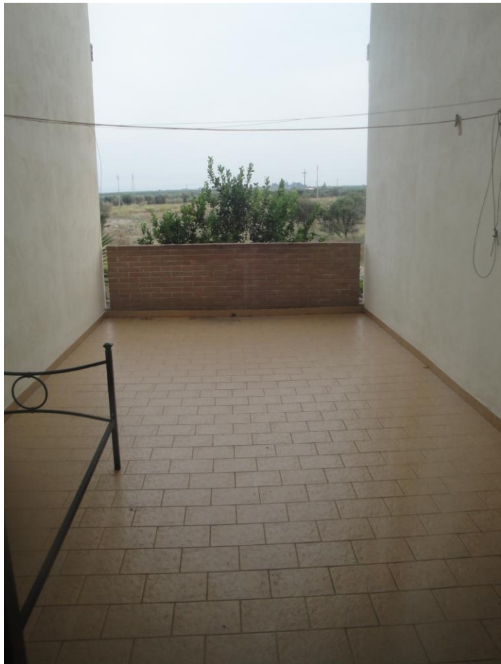
Foto 9: LOTTO 3. Immobile E. Appartamento sito in Cerignola (FG), alla Via dei Tulipani snc, piano T-1-2. Altro balcone in P.1.
