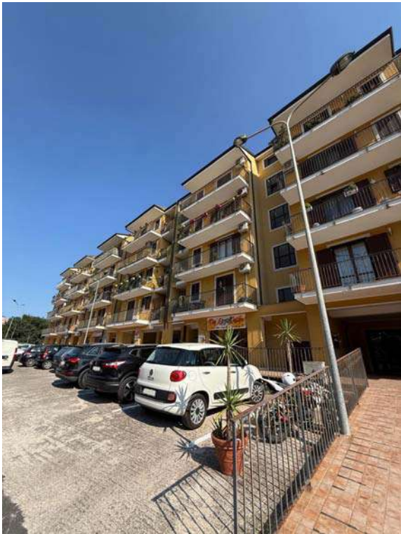
Vista esterna del fabbricato
