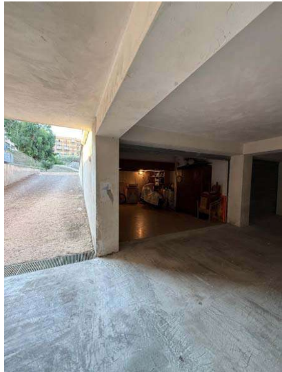
Rampa di accesso al piano seminterrato
