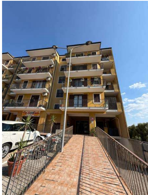
Vista esterna del fabbricato
