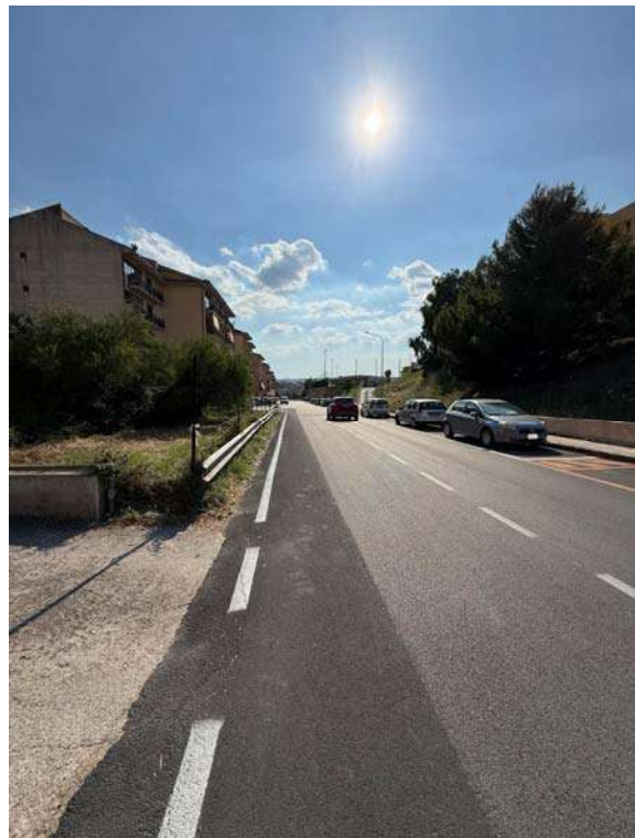
Strada di accesso al fabbricato
