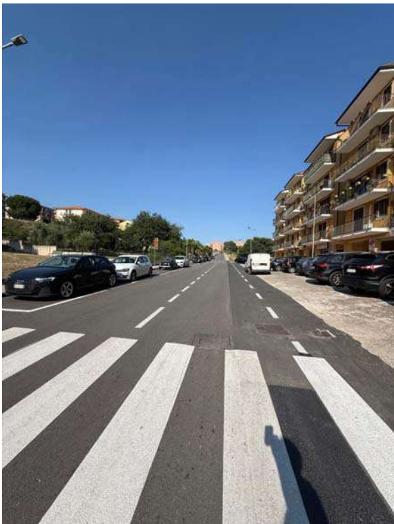
Strada di accesso al fabbricato
