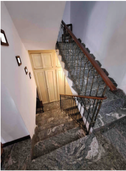
Foto n°19 – Vano Scale Piano Terra.
