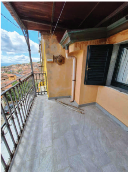
Foto n°39 – Terrazzo Piano Secondo.
