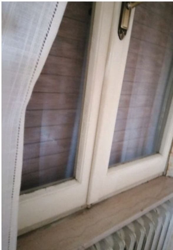
Foto 21 - INFISSI ESTERNI IN LEGNO
