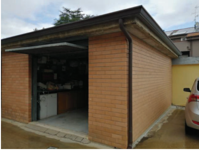
Foto 85 - AUTORIMESSA PROSPETTO SUD-EST
