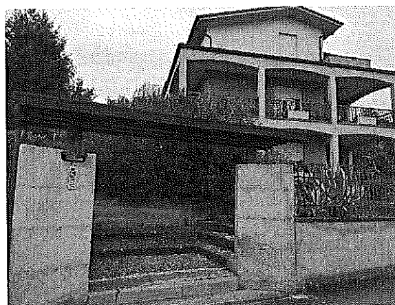
Accesso pedonale e Prospetto Nord-Est
