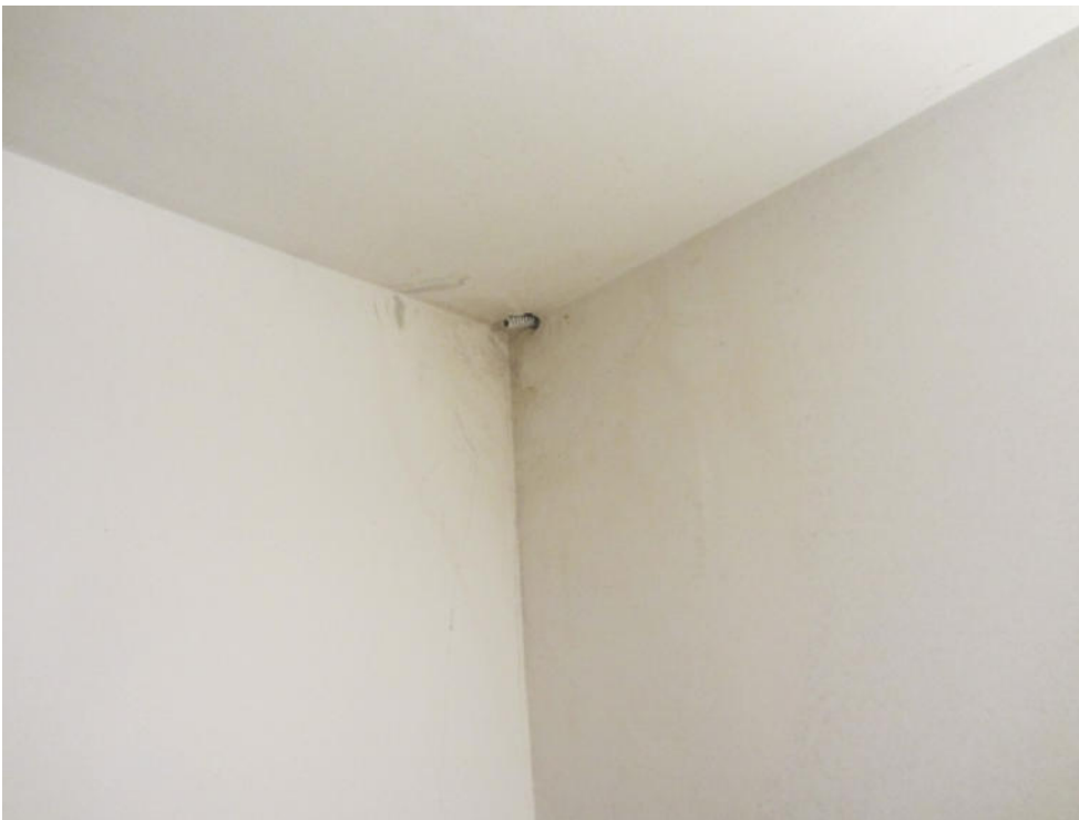
FOTO 1.33_ Infiltrazioni nell'interrato
