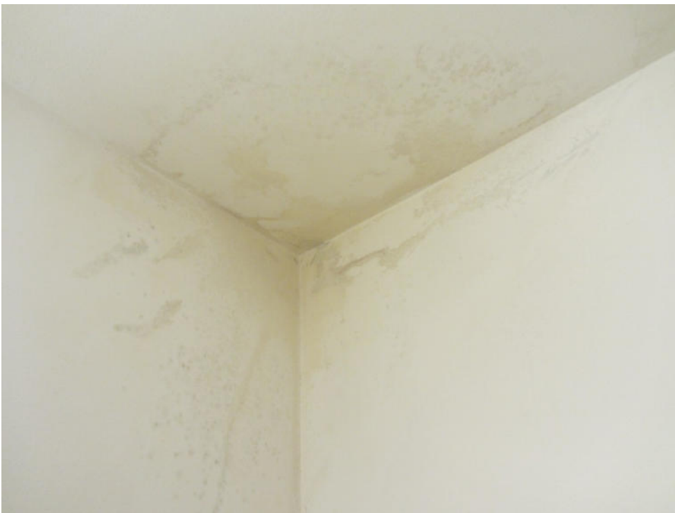
FOTO 1.31_ Infiltrazioni nell'interrato
