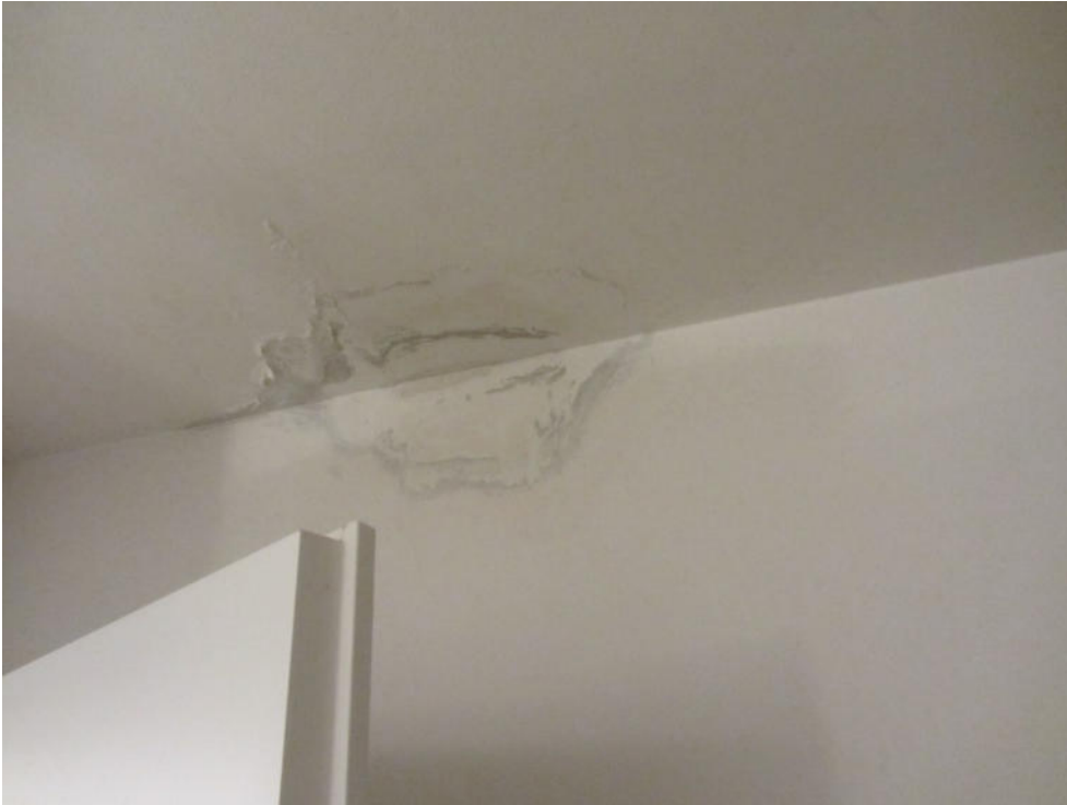
FOTO 1.34_ Infiltrazioni nell'interrato
