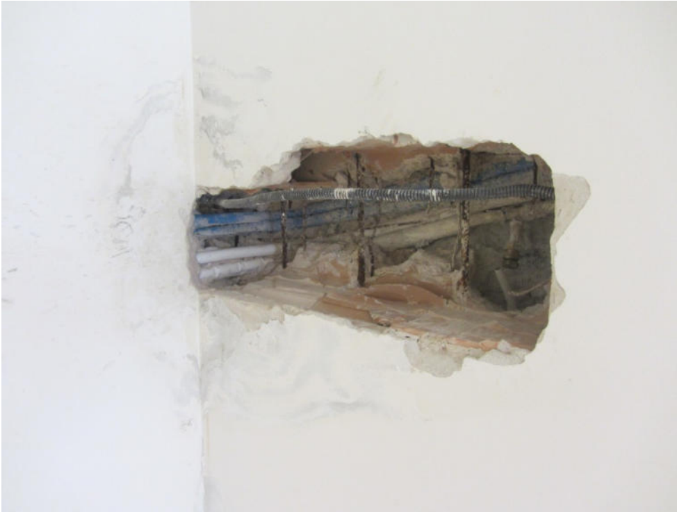
FOTO 1.36_ Ricerca guasto all'impianto di riscaldamento
