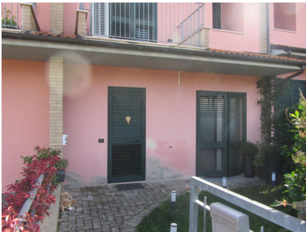
FOTO E.02_ Prospetto fronte PT
