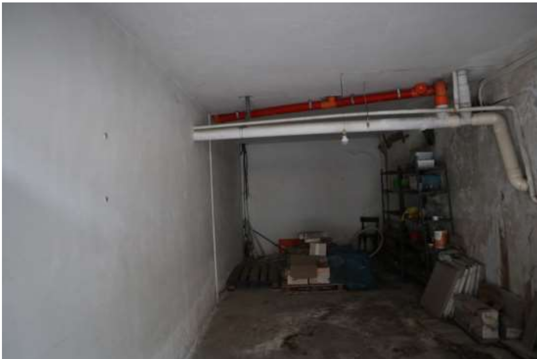
VISTA INTERNA DEL LOCALE DEPOSITO
