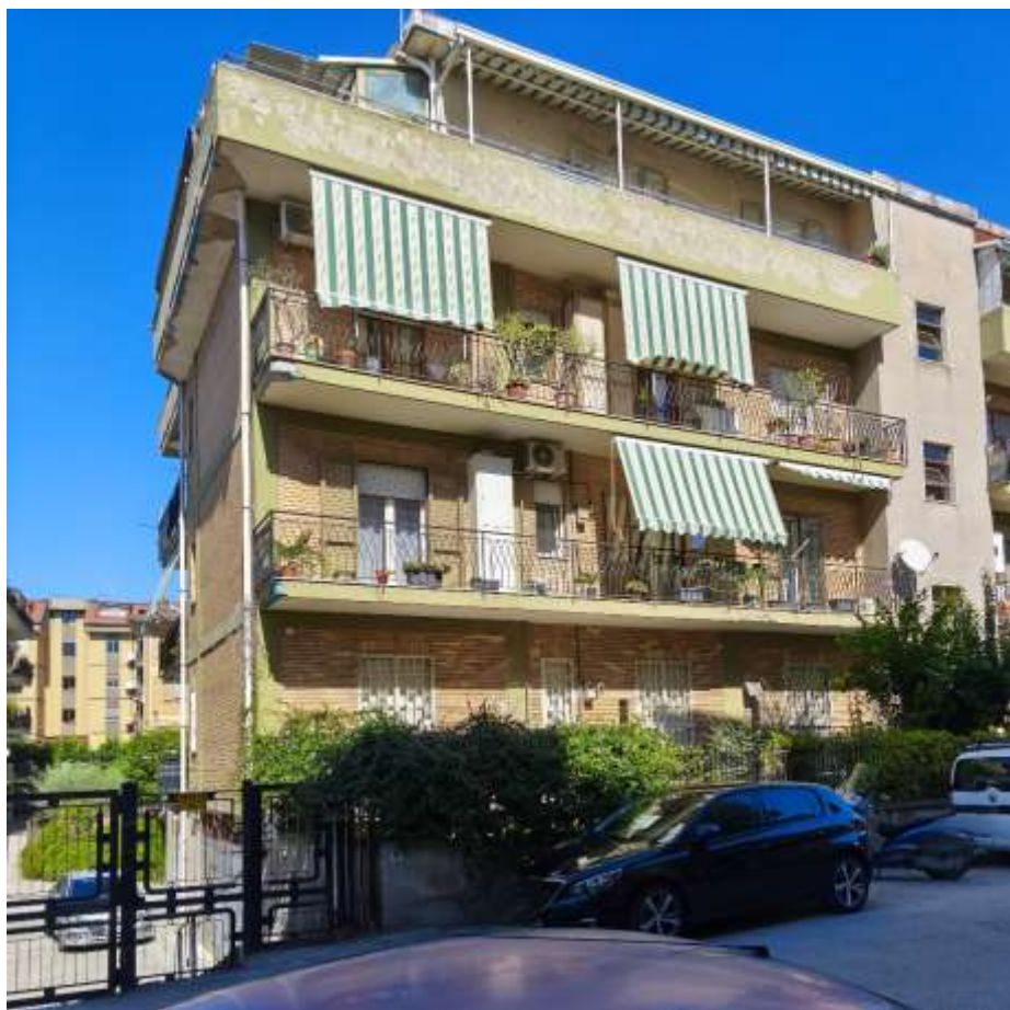
FOTO 1 - 2- 3 Viste esterne del complesso
