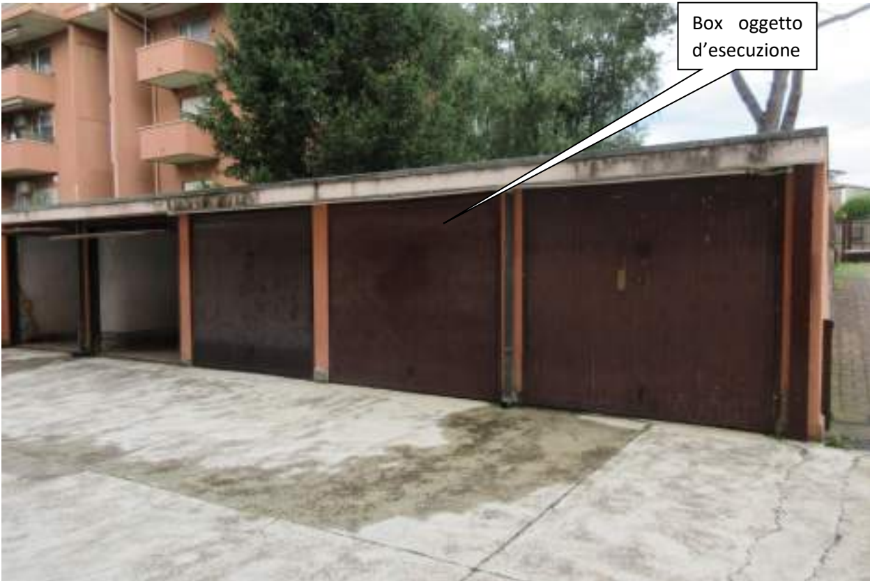
Vista del box esterni con accesso carraio
