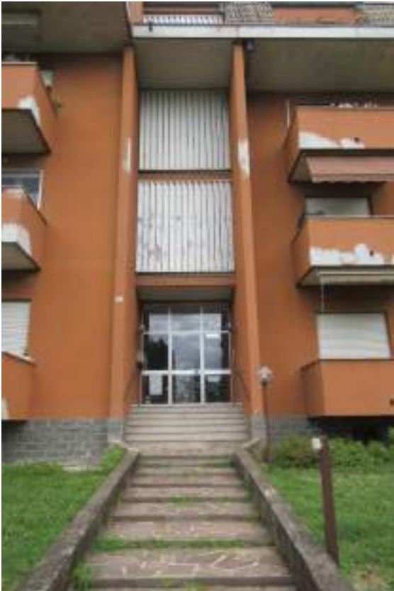
Vista dell'ingresso del condominio
