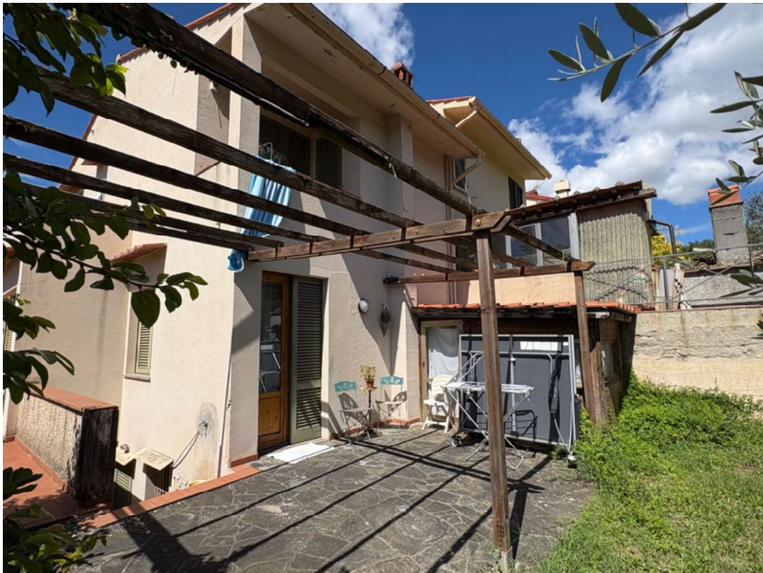
Foto 6 – Vista sul retro. Il ripostiglio in legno è abusivo, da demolire
