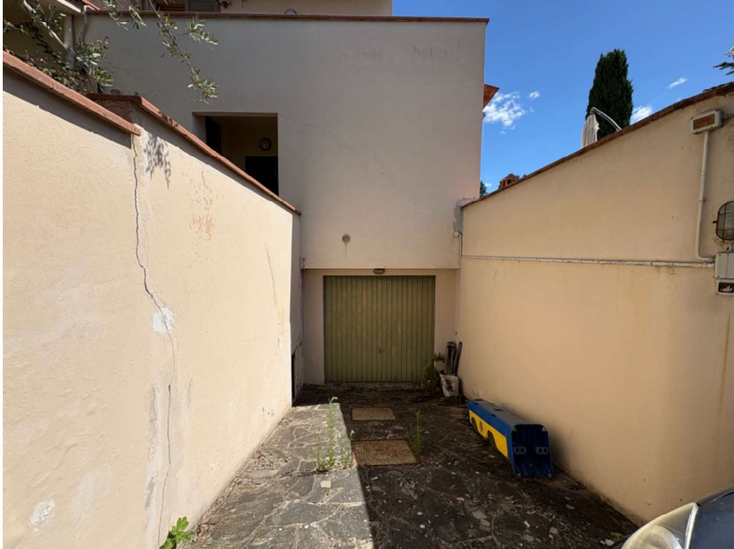
Foto 38 -Accesso al garage
