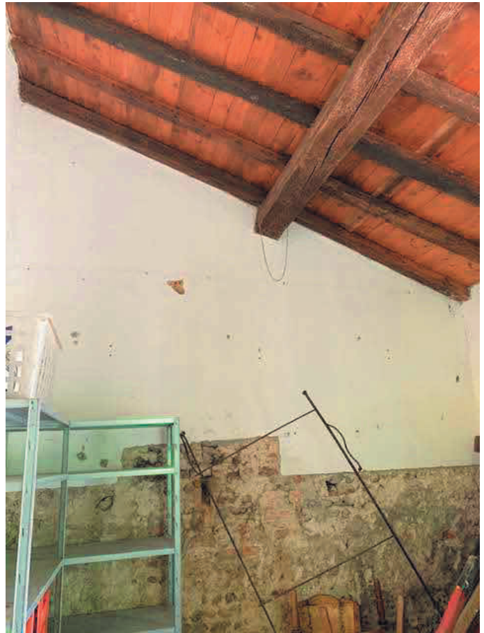
LOCALE AUTOCLAVE (accesso da esterno)
