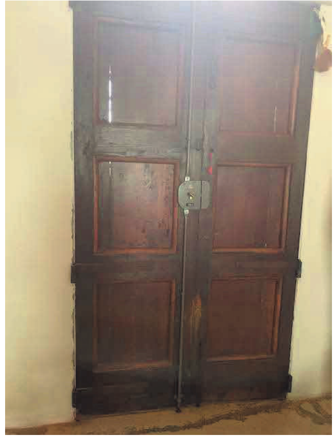
PARTICOLARE PORTA INGRESSO FRONTE
