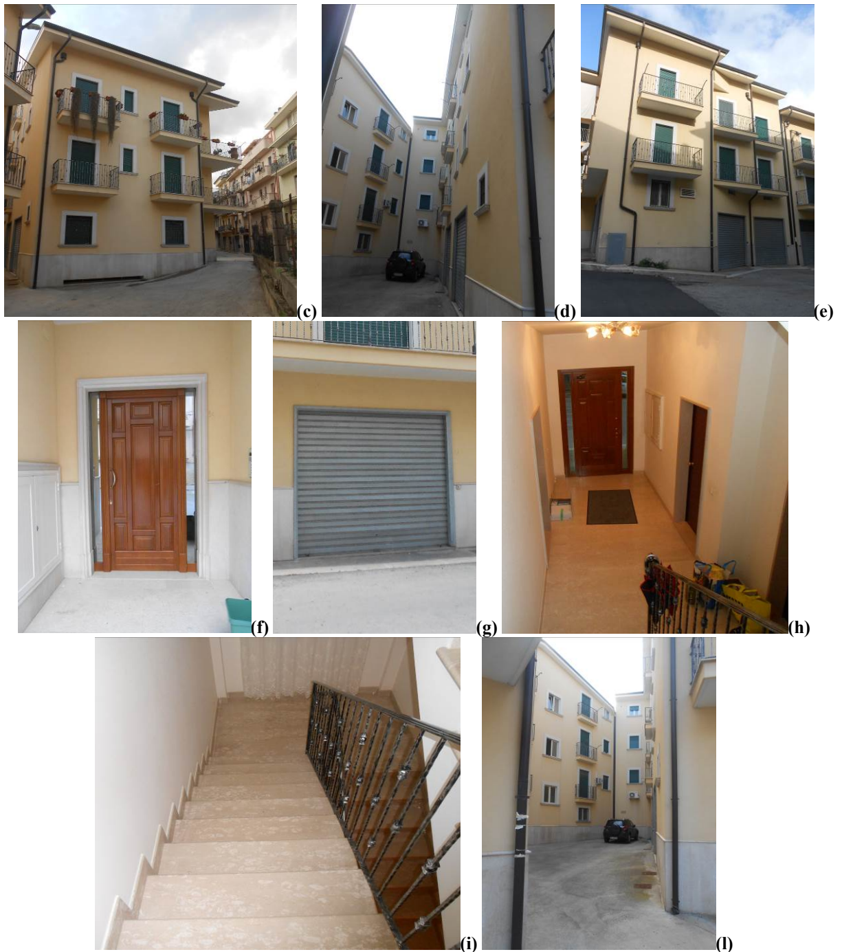
Figura 3. Fabbricato sito tra le vie Cilea, Giro Esterno e Gioachino Rossini: facciata principale su via Giro Esterno angolo via Cilea (a); facciata principale su via Giro Esterno angolo via G. Rossini (b); prospetto di via Cilea (c); facciata interna su area di distacco da altro fabbricato (d); prospetto di via G. Rossini (e); portone condominiale al civico 1/C di via Giro Esterno (f); serranda tipo dei locali a pianterreno (g); androne (h); scalinata comune (i), area esterna comune (l).
