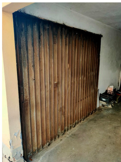
Foto 22: Autorimessa particolare serramda
