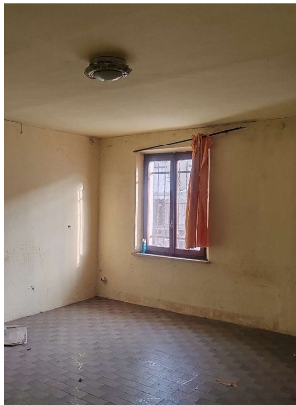
Ripresa fotografica n. 18 Particolare camera P1
