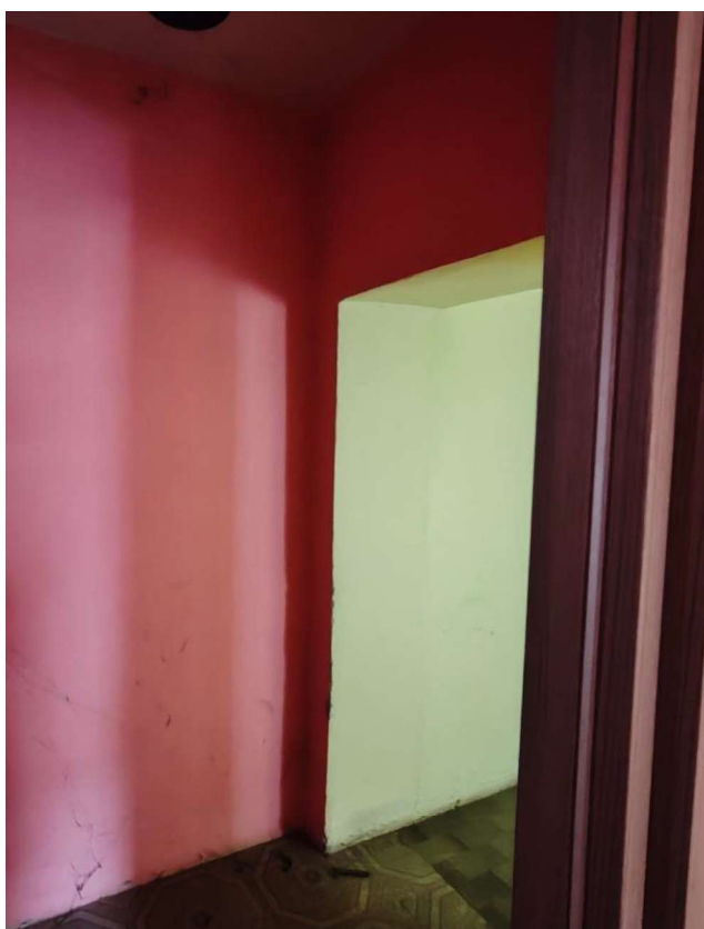
Ripresa fotografica n. 11 Particolare disimpegno P1
