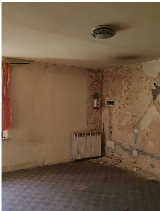
Ripresa fotografica n. 17 Particolare camera P1
