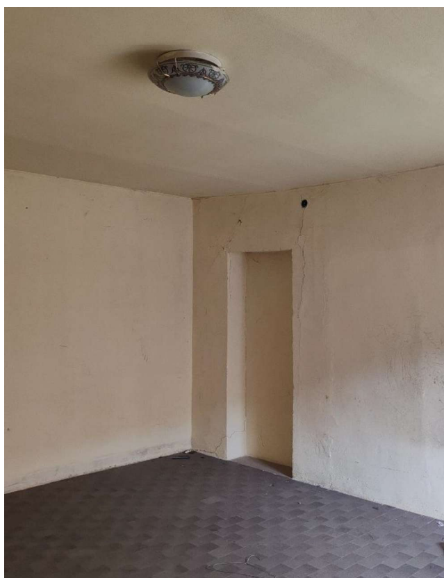
Ripresa fotografica n. 15 Particolare camera P1
