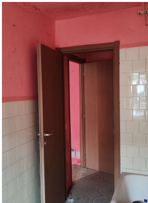
Ripresa fotografica n. 14 Particolare bagno P1
