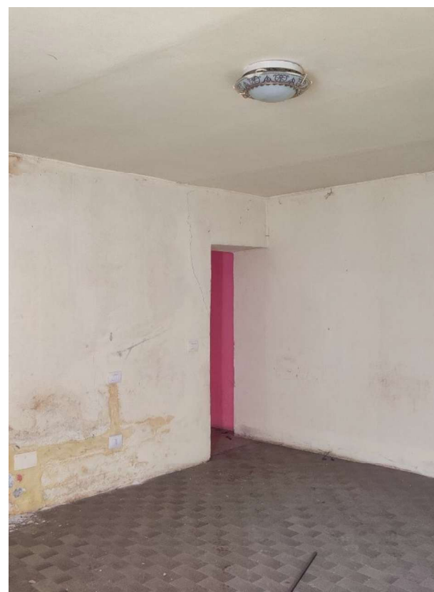
Ripresa fotografica n. 16 Particolare camera P1
