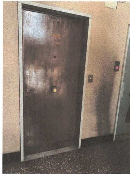
FOTO NR. 3 INGRESSO DAL VANO SCALA
