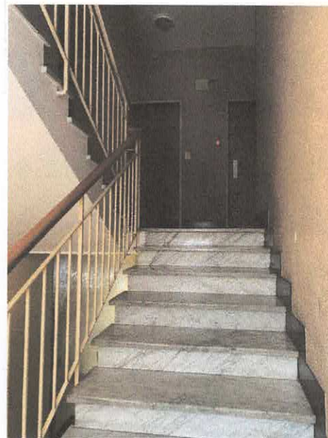
FOTO NR. 4 INGRESSO DAL VANO SCALA
