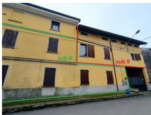
Prospetto nord (via Croce n.47)
