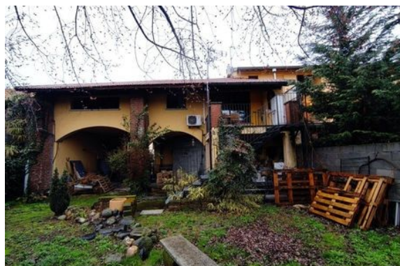
Prospetto sud su corte interna
