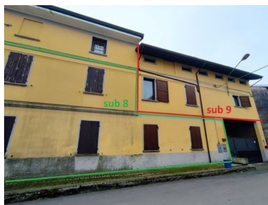
Prospetto nord (via Croce n.47)
